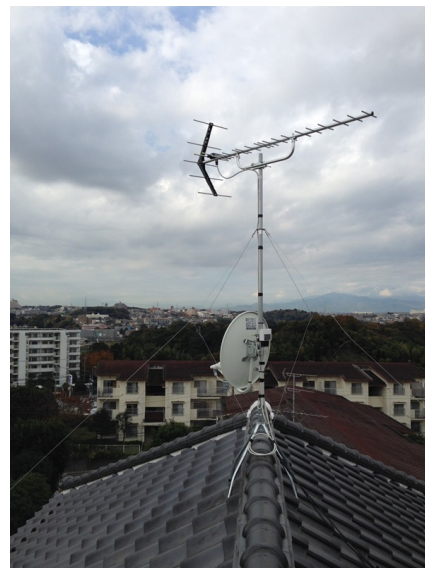
横浜市戸塚区上倉田町 地デジアンテナとBSアンテナ屋根上工事
