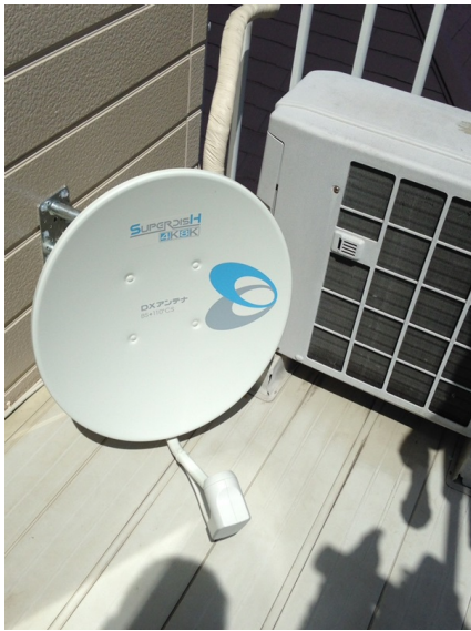
横浜市戸塚区秋葉町 壁面取付 BSアンテナ工事
