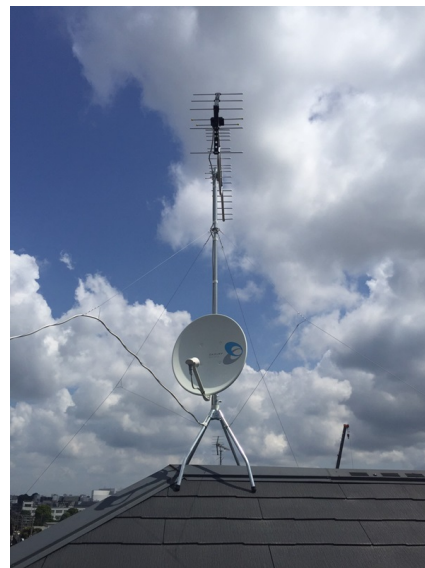
横浜市戸塚区戸塚町 地デジアンテナとBSアンテナ屋根上工事
