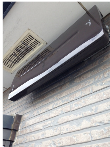
横浜市戸塚区汲沢 垂直偏波受信 壁面取付 デザインアンテナ工事
