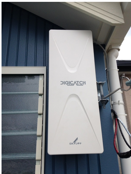
横浜市戸塚区柏尾町 壁面取付 デザインアンテナ工事
