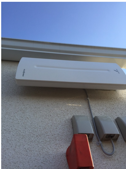
横浜市戸塚区原宿 垂直偏波受信 壁面取付 デザインアンテナ工事
