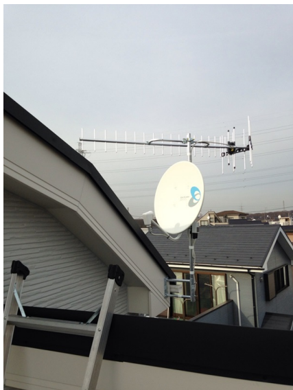
横浜市戸塚区汲沢 壁面取付 地デジアンテナとBSアンテナ工事
