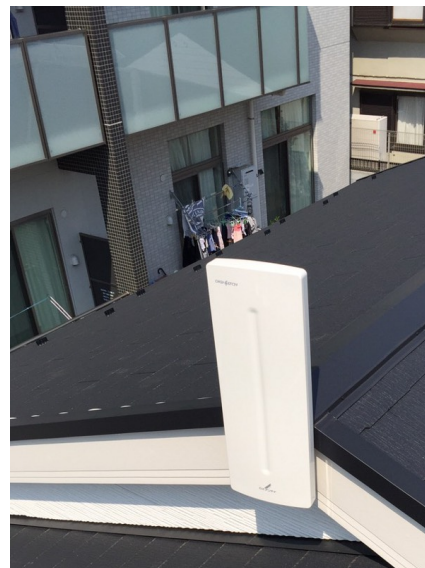
横浜市戸塚区前田町 壁面取付 デザインアンテナ工事
