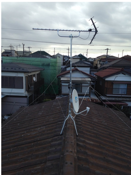
横浜市戸塚区南舞岡 地デジアンテナとBSアンテナ屋根上工事
