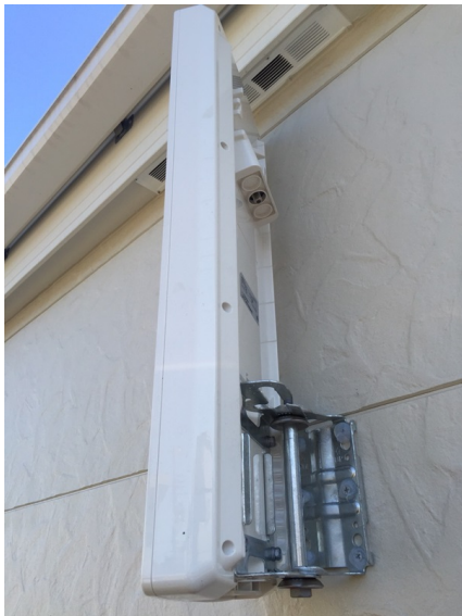
横浜市戸塚区平戸 壁面取付 デザインアンテナ工事
