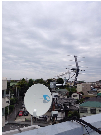
横浜市戸塚区上倉田町 地デジアンテナとBSアンテナ追加工事
