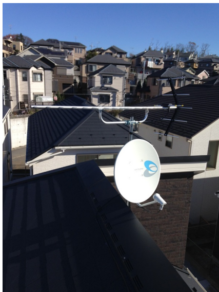
横浜市戸塚区上柏尾町 ひかり建設様物件 壁面取付 地デジアンテナとBSアンテナ工事
