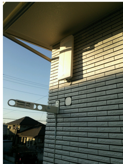
横浜市戸塚区戸塚町 壁面取付 デザインアンテナ工事
