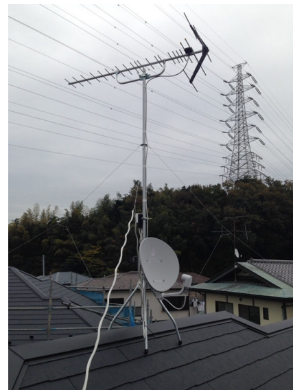
横浜市戸塚区戸塚町 弥生建設様物件 地デジアンテナと持ち込みBSアンテナ屋根上工事
