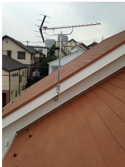
横浜市戸塚区平戸 壁面取付 地デジアンテナ工事
