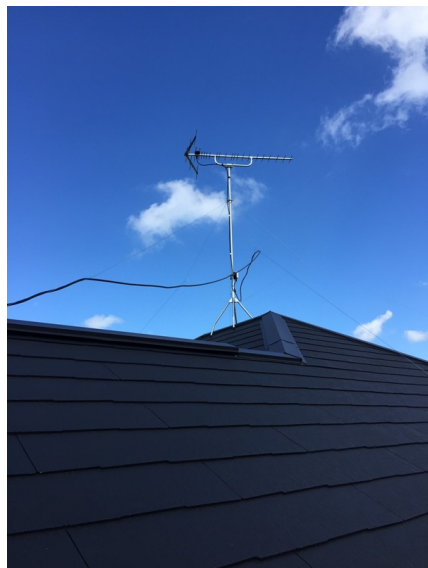
横浜市戸塚区平戸 ハウスメイク様物件 地デジアンテナ屋根上工事
