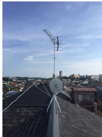
横浜市戸塚区深谷町 アーネストワン様物件 地デジアンテナとBSアンテナ屋根上工事
