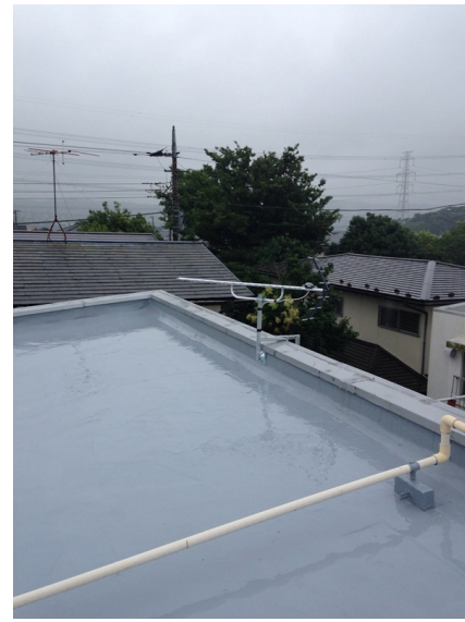
横浜市栄区元大橋 地デジアンテナ屋根上工事
