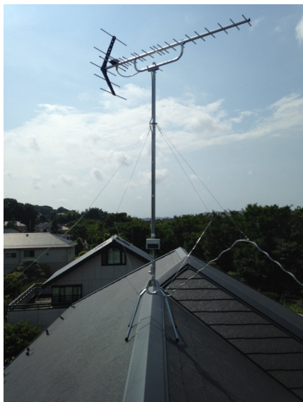
横浜市栄区中野町 弥生建設様物件 地デジアンテナ屋根上工事
