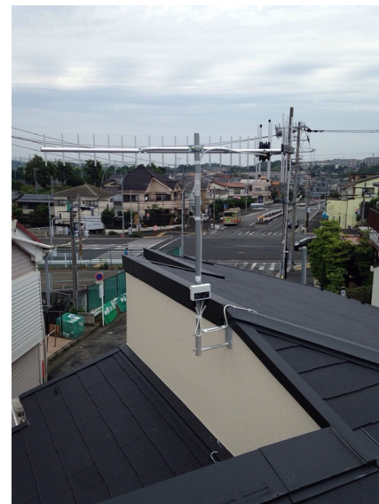
横浜市栄区长沼町 エクシートホーム様物件 垂直偏波受信 壁面取付 地デジアンテナ工事
