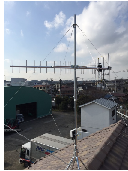
横浜市栄区飯島町 地デジアンテナ工事後の外観
