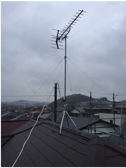
横浜市栄区若竹町 地デジアンテナ屋根上工事
