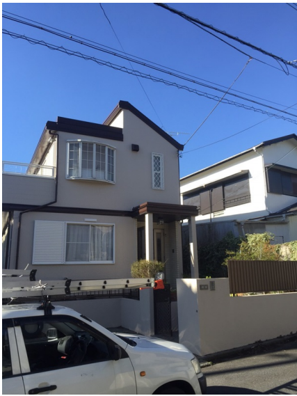
横浜市栄区本郷台 地デジアンテナ屋根裏工事
