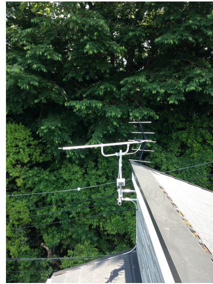
横浜市栄区飯島町 ひかり建設様物件 壁面取付 地デジアンテナ工事
