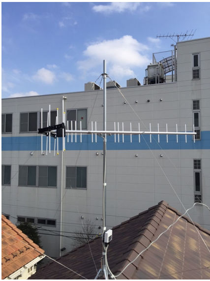
横浜市栄区飯島町 垂直偏波受信 地デジアンテナ屋根上工事
