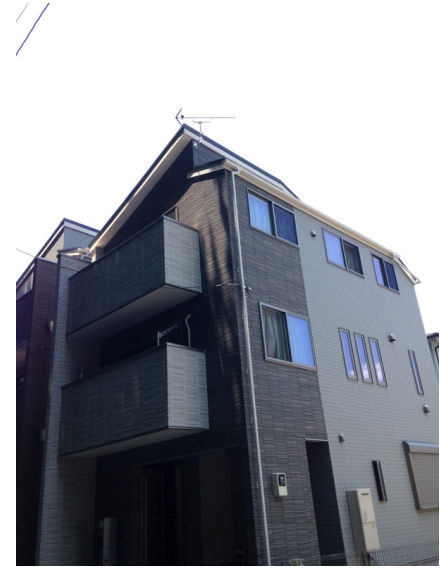
横浜市栄区飯島町 ひかり建設様物件 地デジアンテナ工事後の外観
