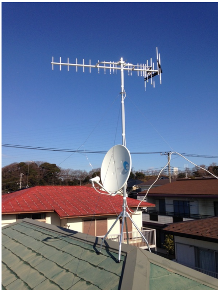
横浜市栄区犬山町 地デジアンテナとBSアンテナ屋根上工事
