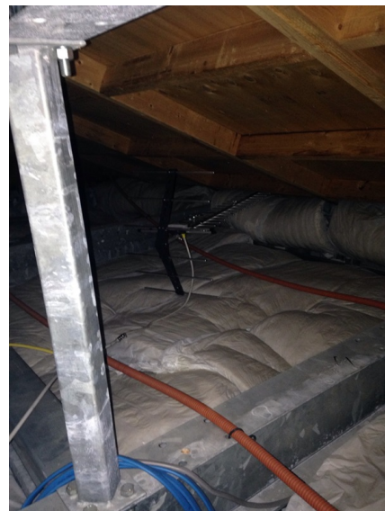
横浜市栄区若竹町 MKハウス様物件 地デジアンテナ屋根裏工事
