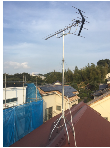
横浜市栄区公田 地デジアンテナ屋根上工事
