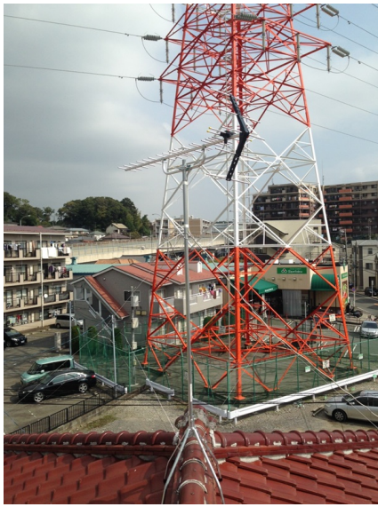
横浜市栄区飯島町 地デジアンテナとBSアンテナ屋根上工事
