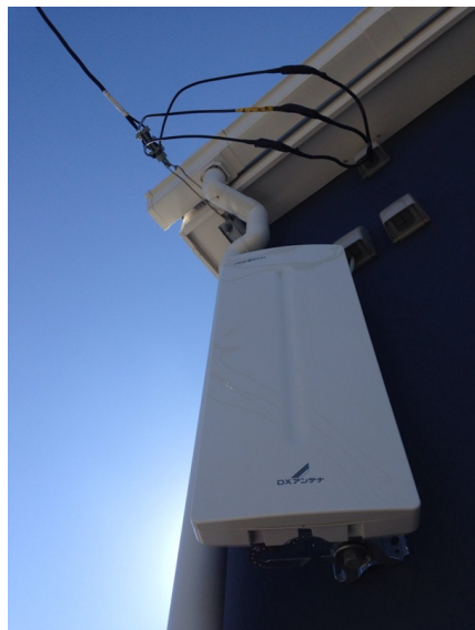
横浜市栄区野七里 ベンハウス様物件 壁面取付 デザインアンテナ工事
