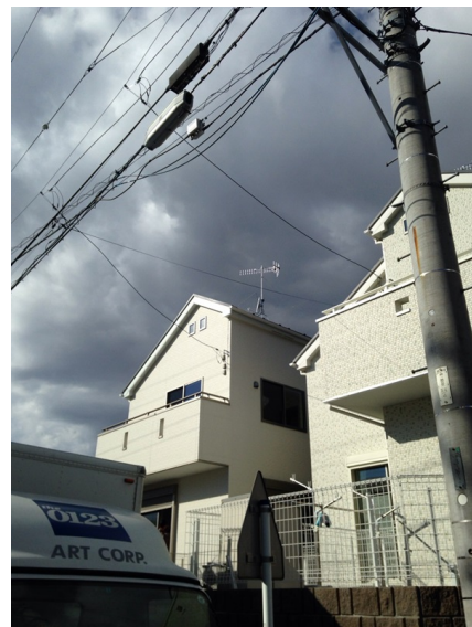
横浜市栄区元大橋 地デジアンテナとBSアンテナ工事後の外観
