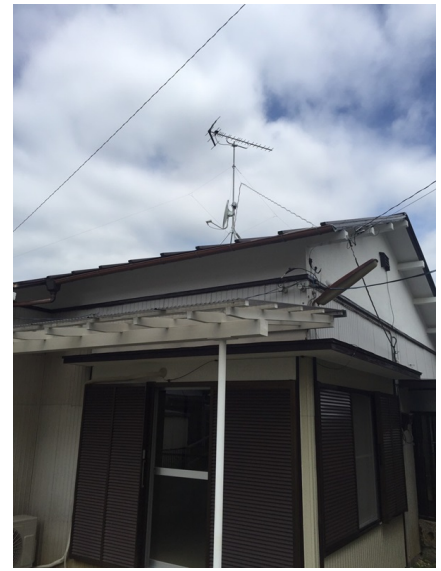
横浜市栄区笠間 地デジアンテナとBSアンテナ工事後の外観
