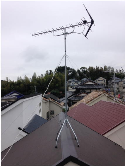
横浜市栄区 地デジアンテナ屋根上工事
