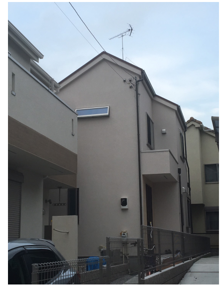
横浜市栄区公田 地デジアンテナ屋根上工事後の外観
