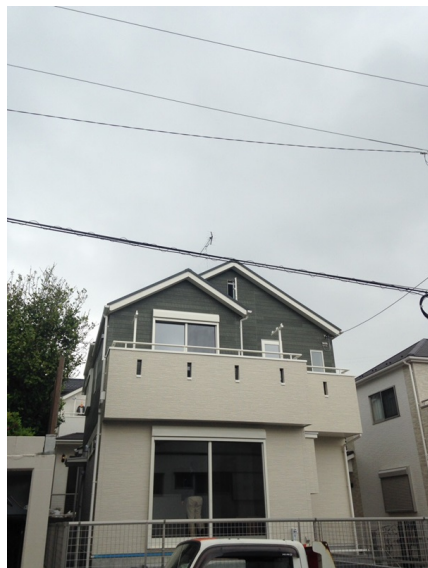
横浜市栄区若竹町 横浜建物様物件 地デジアンテナとBSアンテナ工事後の外観
