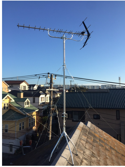
横浜市栄区亀井町 地デジアンテナ屋根上工事
