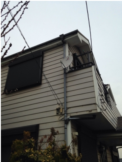
横浜市中区竹之丸 BSアンテナ工事後の外観
