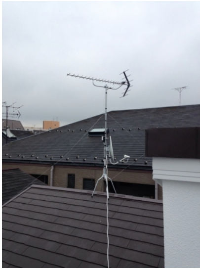
横浜市中区塩崎町 松野建設様物件 地デジアンテナとBSアンテナ屋根上工事
