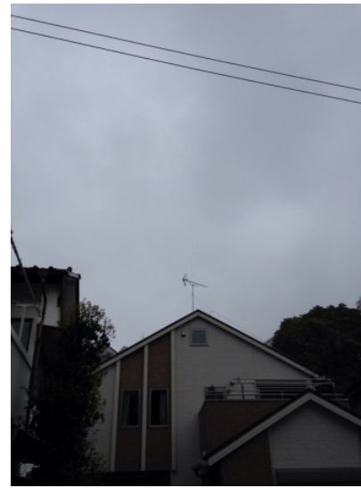
横浜市中区本牧満坂 住友不動産様物件 地デジアンテナ工事後の外観
