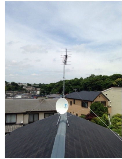
横浜市中区本牧荒井 地デジアンテナとBSアンテナ屋根上工事
