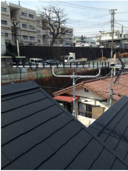
横浜市中区竹之丸 大樹建設様物件 壁面取付 地デジアンテナ工事
