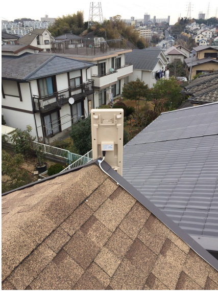
横浜市港南区港南台 破風板設置 デザインアンテナ工事
