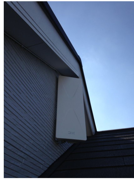
港南区大久保 壁面取付 デザインアンテナ工事
