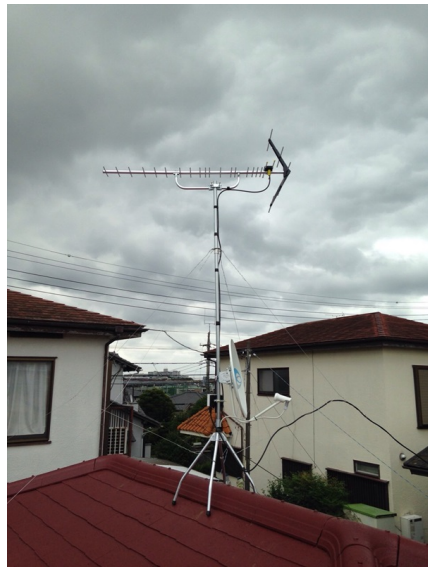
横浜市港南区芹が谷 カナエルリフォーム様物件 地デジアンテナとBSアンテナ屋根上工事
