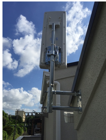
横浜市港南区日野 三光エンジニアリング様物件 壁面取付 デザインアンテナ工事
