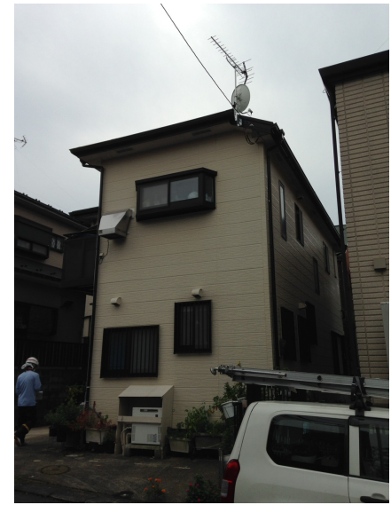
横浜市港南区日野南 地デジアンテナとBSアンテナ工事後の外観
