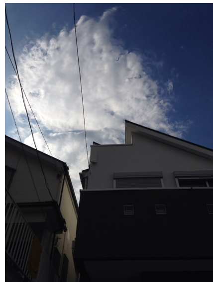
横浜市港南区日野南 ホークワン様物件 垂直偏 波受信 壁面取付 地デジアンテナ工事
