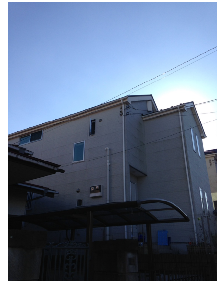
港南区大久保 デザインアンテナ工事後の外観
