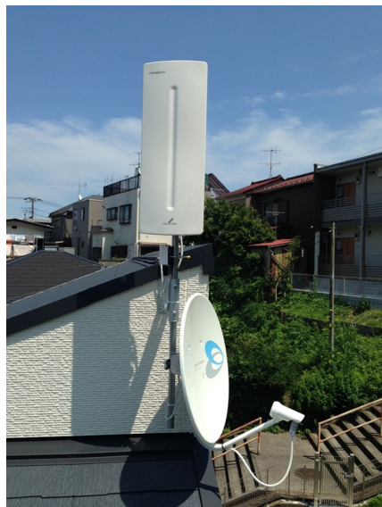
横浜市港南区上永谷 プリンシパルホーム様物件 壁面取付 デザインアンテナとBSアンテナ工事
