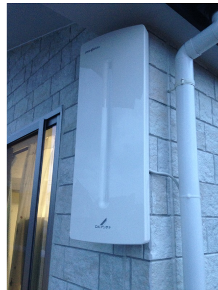
横浜市港南区港南台 アイオイハウジング様物件 壁面取付 デザインアンテナ工事
