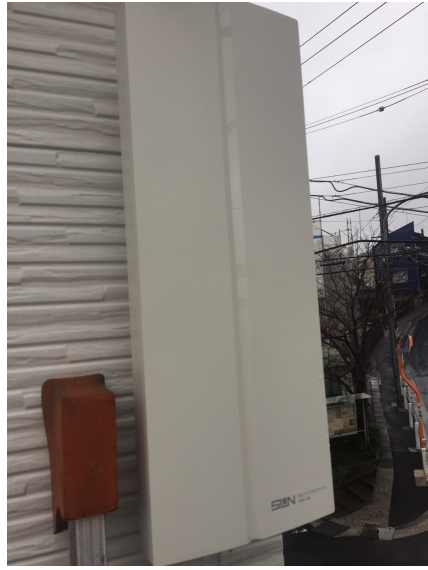
横浜市港南区笹下 ホークワン様ご物件 壁面取付 デザインアンテナ工事
