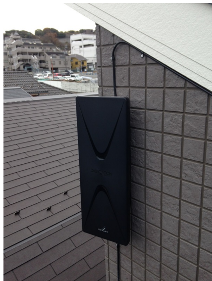
横浜市港南区港南台 アサカワホーム様物件 壁面取付 デザインアンテナ工事
