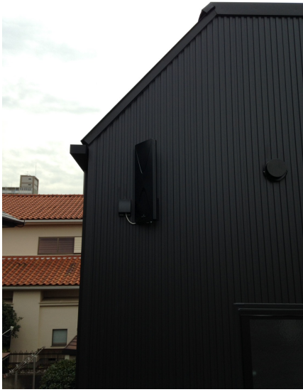
港南区港南台 ラムズカンパニー様ご物件 壁面取付 デザインアンテナ工事
