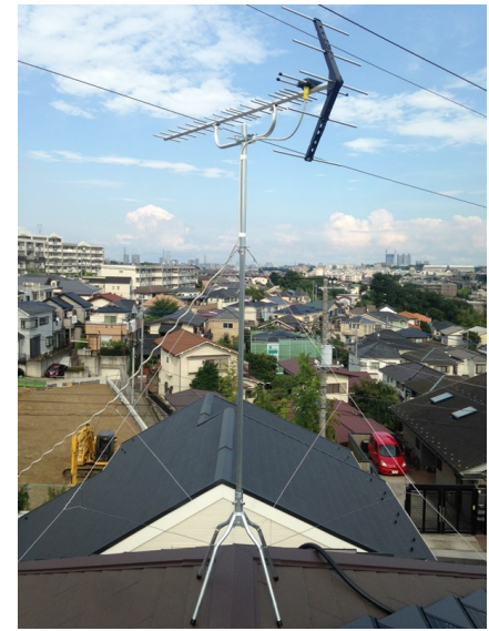
横浜市港北区日吉本町 地デジアンテナ屋根上工事
