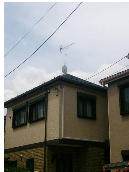
横浜市港北区樽町 地デジアンテナとBSアンテナ工事後の外観
