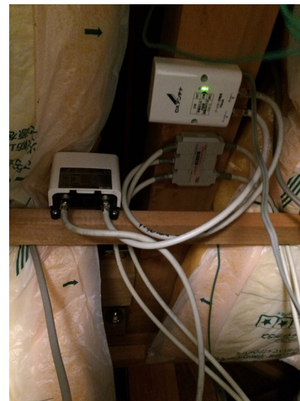
横浜市港北区日吉 ベランダ取付 地デジアンテナ工事
