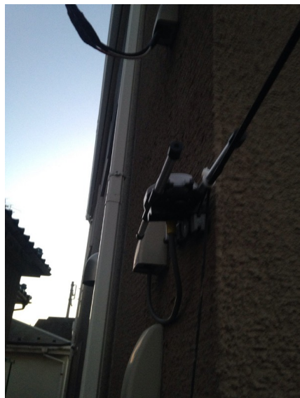
横浜市港北区新吉田東 壁面取付 BSアンテナ 工事
