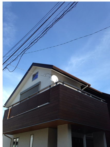
横浜市港北区下田町 デザインアンテナとBSアンテナ工事後の外観
