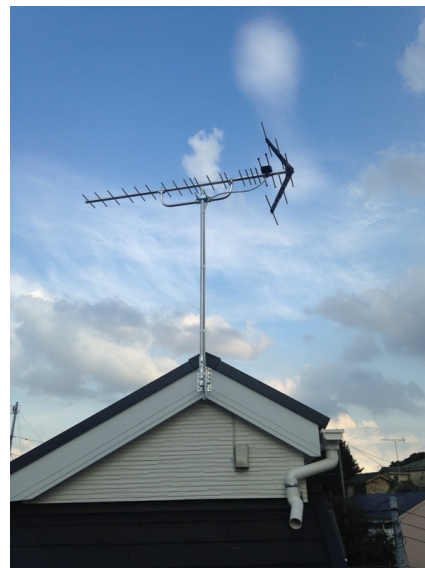
横浜市港北区篠原東 壁面取付 地デジアンテナ工事
