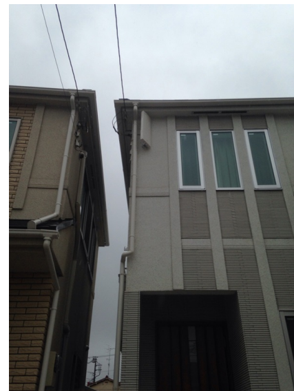
横浜市港北区樽町 デザインアンテナ工事後の外観
