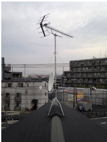
横浜市港北区菊名 地デジアンテナとBSアンテナ屋根上工事
