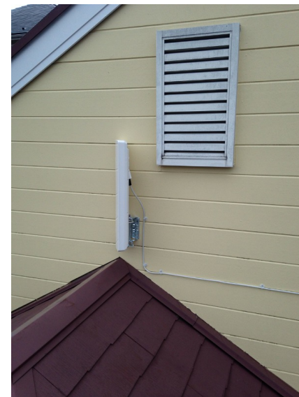
横浜市港北区烏山町 壁面取付 デザインアンテナ 工事
