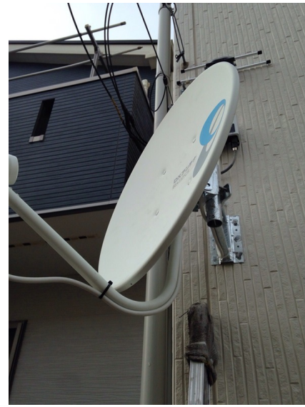
横浜市港北区日吉 壁面取付 BSアンテナ工事
