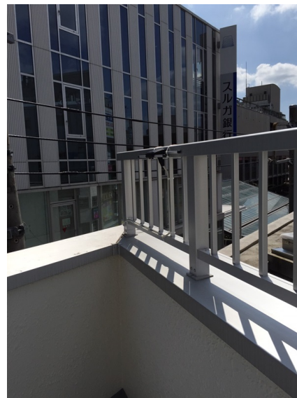
横浜市港北区師岡町 ブースター取付工事
