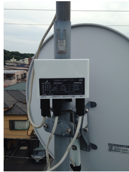
横浜市港北区日吉本町 ブースター交換工事
