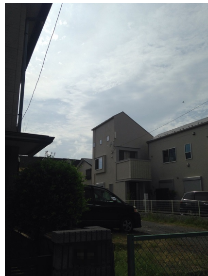
横浜市港北区新吉田東 デザインアンテナとBSアンテナ工事後の外観
