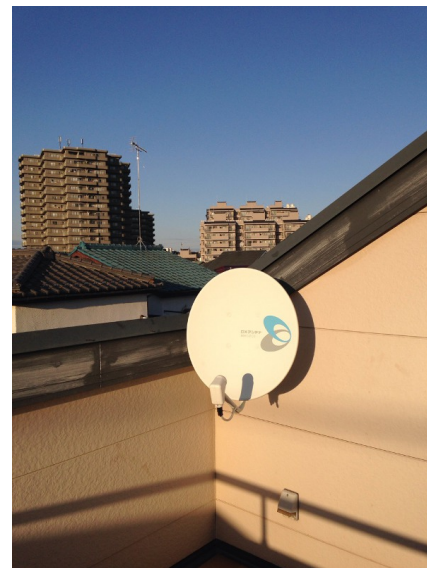
横浜市港北区日吉 壁面取付 地デジアンテナ工 事
