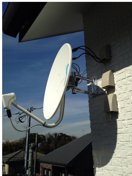
横浜市港北区下田町 壁面取付 BSアンテナ工事
