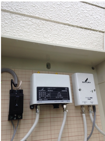
横浜市港北区仲手原 ブースター電源部 ブースター本体
