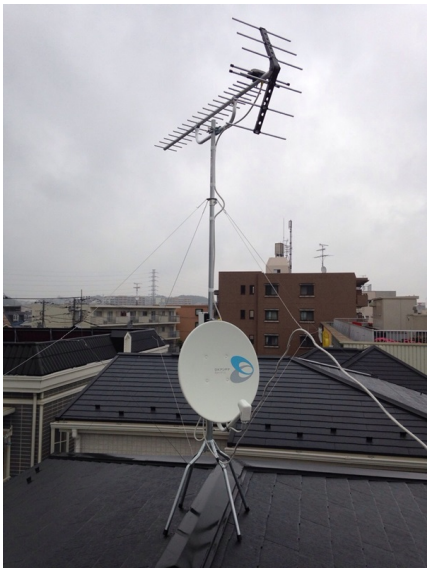
横浜市港北区綱島西 地デジアンテナとBSアンテナ工事
