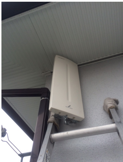
横浜市港北区仲手原 壁面取付 デザインアンテナ工事
