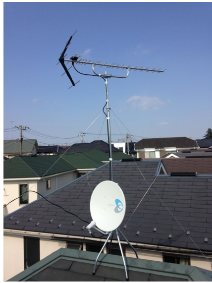
横浜市港北区下田町 地デジアンテナとBSアンテナ屋根上工事
