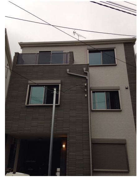
横浜市港北区綱島西 地デジアンテナとBSアンテナ工事後の外観
