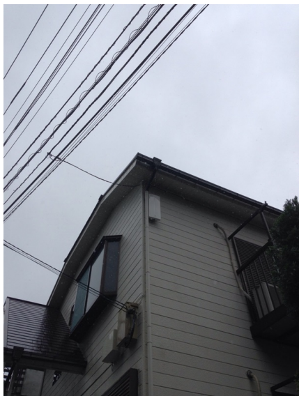
横浜市港北区仲手原 デザインアンテナ工事後の外観
