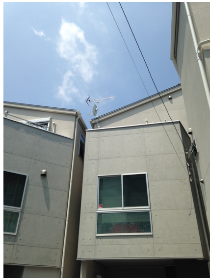
横浜市港北区大豆戸町 地デジアンテナとBSアンテナ工事後の外観
