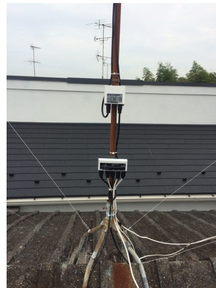
横浜市港北区新吉田東 ブースター交換工事
