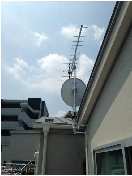
横浜市港北区大豆戸町 壁面取付 地デジアンテナとBSアンテナ工事
