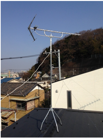
横浜市港北区箕輪町 オープンハウス様物件 地デジアンテナ屋根上工事
