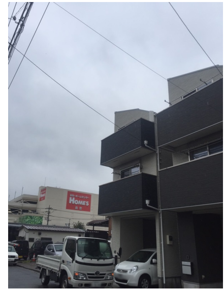
横浜市港北区高田西 オープンハウス様物件 デザインアンテナ工事後の外観
