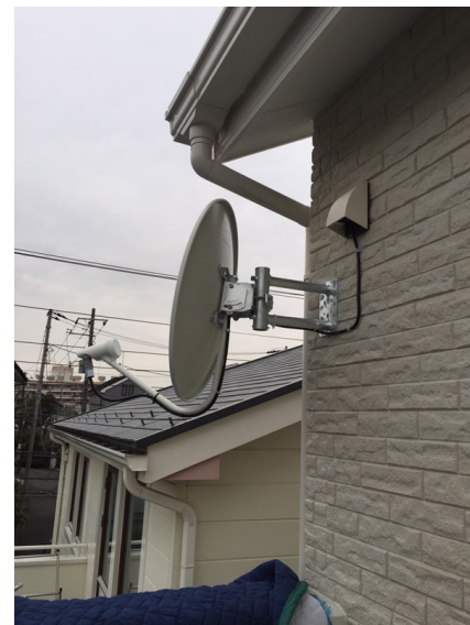
横浜市港北区日吉本町 ジューテックホーム様物件
