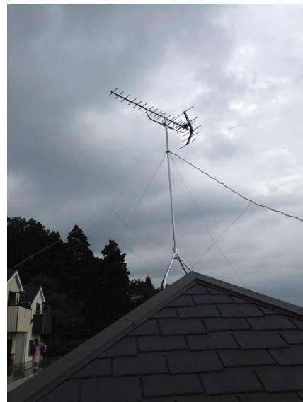
横浜市港北区小机町 工藤建設様物件 地デジアンテナ屋根上工事
