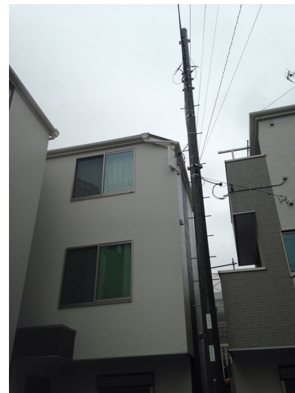
横浜市港北区日吉 ハウスプラン様物件 デザインアンテナ工事後の外観
