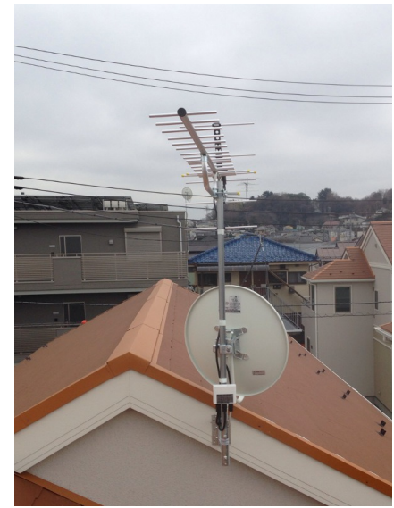
横浜市港北区師岡町 ライズ様物件 デザインアンテナ屋根裏工事
