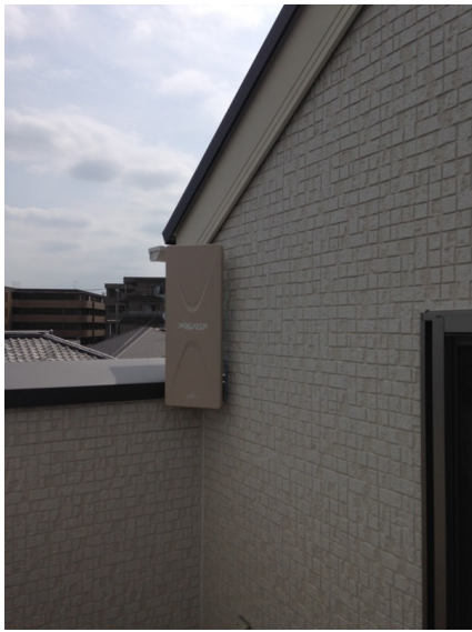
横浜市港北区大倉山 フォーライフ様物件 壁面取付 デザインアンテナ工事
