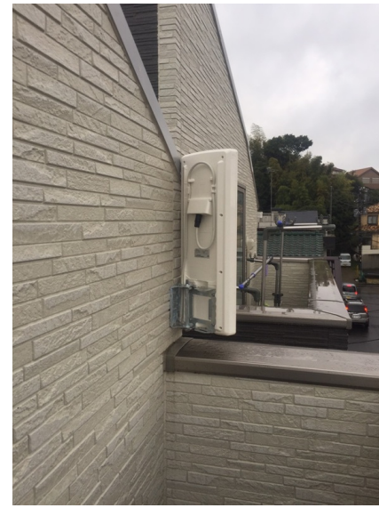
横浜市港北区高田西 オープンハウス様物件 壁面取付 デザインアンテナ工事
