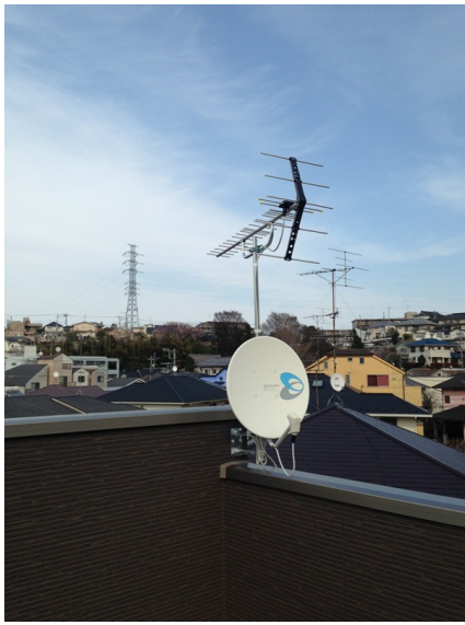
横浜市港北区菊名 グローバルアーキテクト様物件 壁面取付 地デジアンテナとBSアンテナ工事
