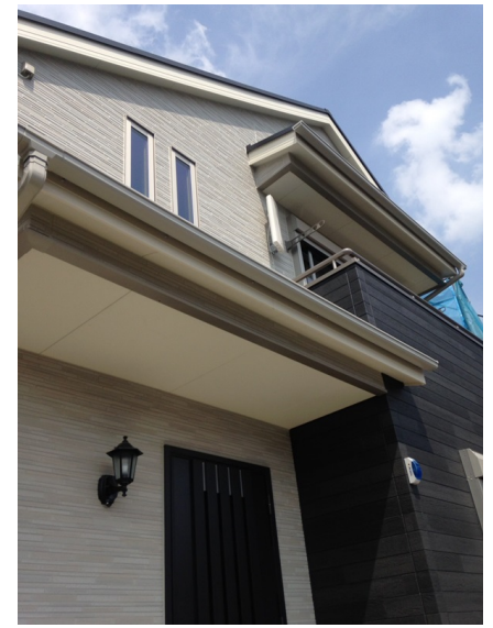
横浜市港北区日吉 タマック様物件 デザインアンテナ工事後の外観
