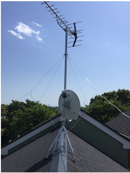
横浜市港北区日吉本町 黒澤建設様物件 地デジアンテナとBSアンテナ屋根上工事
