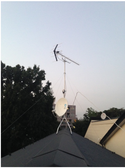
横浜市港北区吉本町 アースワーク様物件 地デジアンテナとBSアンテナ屋根上工事
