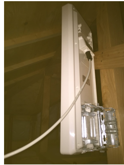
横浜市港北区下田町 成建様物件 デザインアンテナ屋根裏工事
