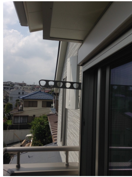
横浜市港北区日吉 タマック様物件 壁面取付 デザインアンテナ工事
