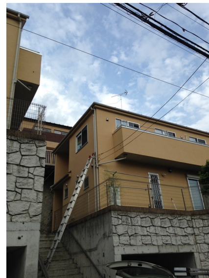
横浜市港北区小机町 工藤建設様物件 地デジアンテナ工事後の外観
