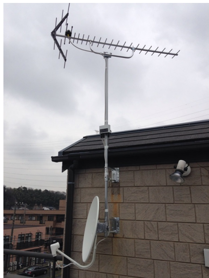
横浜市港北区新吉田東 鹿兒島建設様物件 壁面取付 地デジアンテナとBSアンテナ工事
