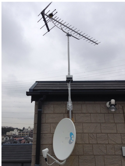
横浜市港北区新吉田東 鹿兒島建設様物件 壁面取付 地デジアンテナとBSアンテナ工事
