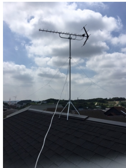
横浜市青葉区美しが丘西 地デジアンテナ屋根上工事
