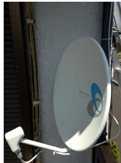
横浜市青葉区美しが丘西 壁面取付 BSアンテナ 工事
