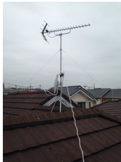
横浜市青葉区桂台 地デジアンテナとBSアンテナ屋根上工事
