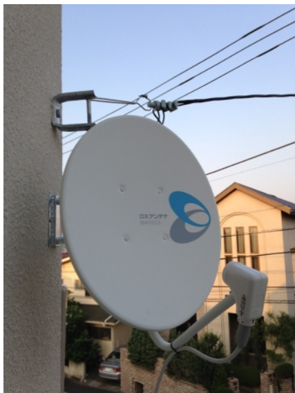
横浜市青葉区青葉台 壁面取付 BSアンテナ工事
