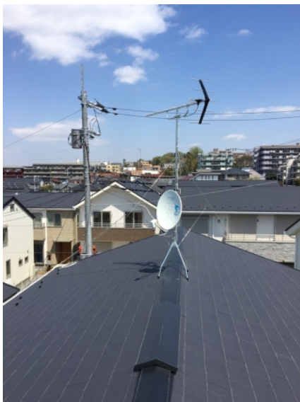
横浜市青葉区市ヶ尾町 ナイスホーム様物件 地デジアンテナとBSアンテナ屋根上工事
