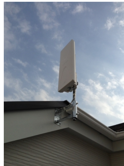
青葉区あかね台 飯田産業様物件 壁面取付 デザインアンテナ工事
