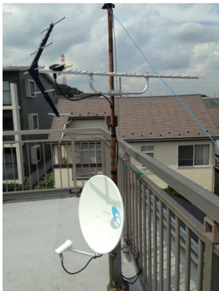
横浜市青葉区梅が丘 旭化成様物件 地デジアンテナとBSアンテナ交換工事
