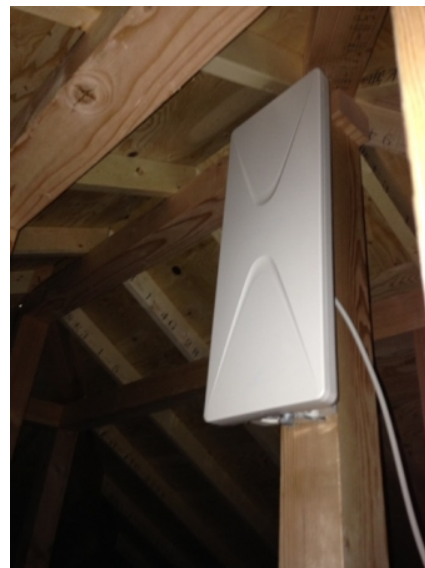
横浜市青葉区あかね台 サンケイホーム様物件 デザインアンテナ屋根裏工事
