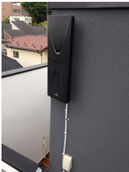
横浜市青葉区藤が丘 カキザワ工務店様物件 壁面取付 デザインアンテナ工事
