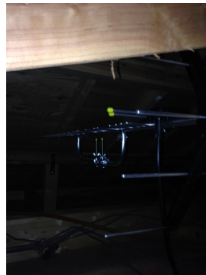
横浜市青葉区鴨志田町 アーネストワン様物件 地デジアンテナ屋根裏工事
