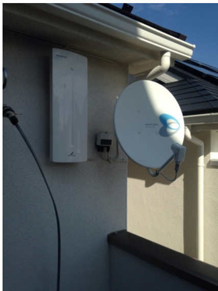
横浜市青葉区あざみ野 正建様物件 壁面取付 デザインアンテナとBSアンテナ工事
