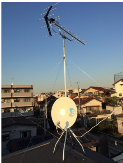
横浜市青葉区さつきが丘 ひかり建設様物件 地デジアンテナとBSアンテナ屋根上工事
