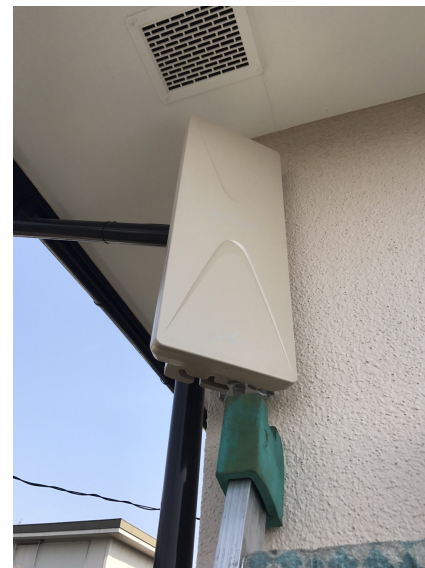
横浜市青葉区大場町 壁面取付 デザインアンテナ工事
