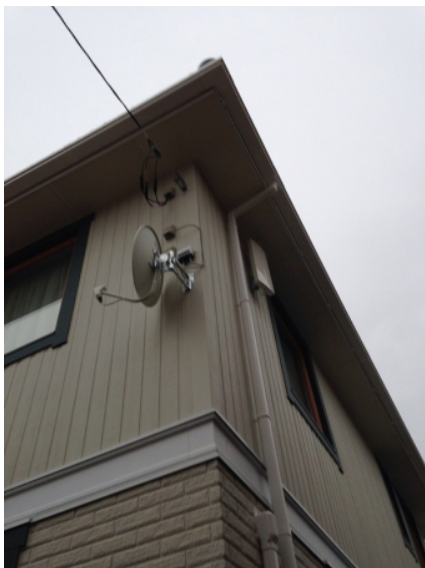
横浜市青葉区美しが丘 スウェーデンハウス様物件 壁面取付 デザインアンテナとBSアンテナ工事
