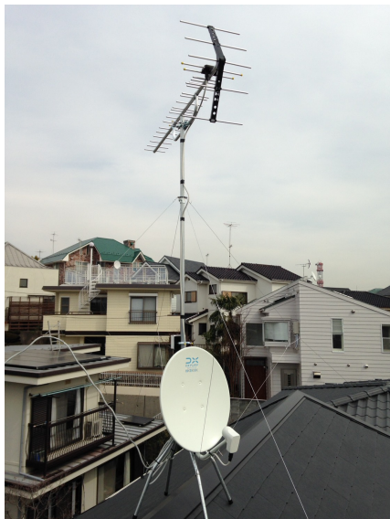
青葉区市ヶ尾町 よこはま建設様ご物件 屋根上設置 八木式アンテナとBS/CSアンテナ
