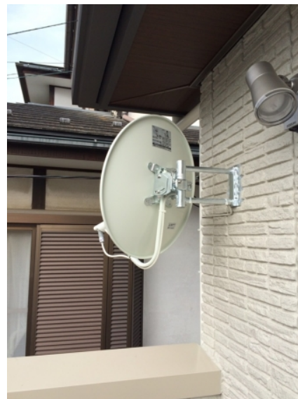
横浜市青葉区あざみ野 積水ハウス様物件 壁面取付 BSアンテナ工事
