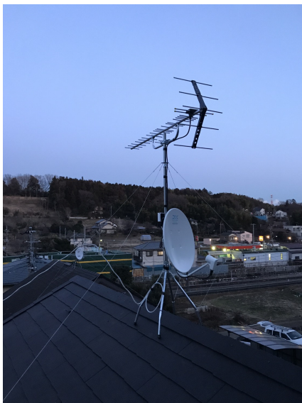
横浜市青葉区恩田町 三井ホーム様ご物件 屋根上設置 八木式アンテナとBS/CSアンテナ工
