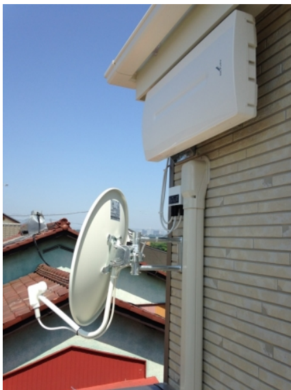
相模原市南区磯部 垂直偏波受信 壁面取付 デザインアンテナとBSアンテナ工事
