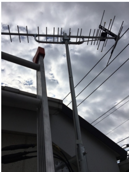
相模原市南区大野台 壁面取付 地デジアンテナ工事
