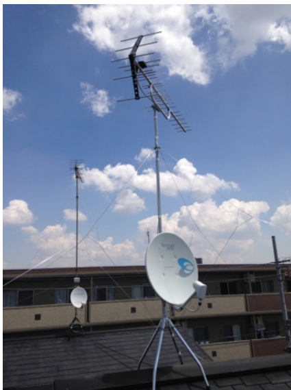
相模原市南区相模台 地デジアンテナとBSアンテナ意屋根上工事
