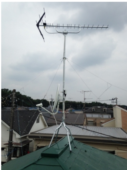
相模原市南区大沼 地デジアンテナとBSアンテナ屋根上工事
