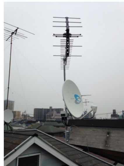
相模原市南区相模台 壁面取付 地デジアンテナとBSアンテナ工事
