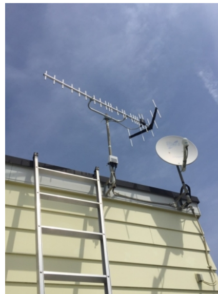
茅ヶ崎市今宿 垂直偏波受信 壁面取付 デザインアンテナ工事
