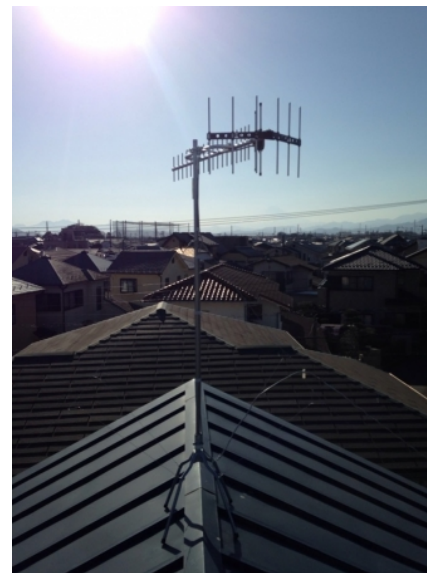
茅ヶ崎市萩園 垂直偏波受信 地デジアンテナ屋根上工事
