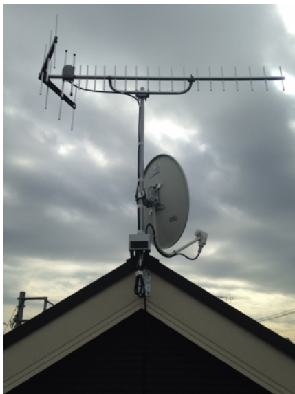
茅ヶ崎市中海岸 ハートフルホーム様物件 デザインアンテナとBSアンテナ工事後の外観
