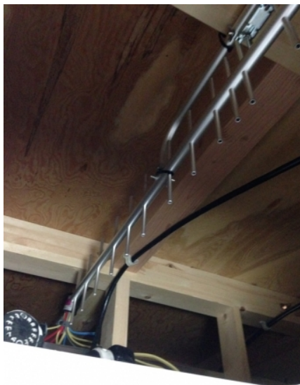
茅ヶ崎市中島 サンケイホーム様物件 地デジアンテナ屋根裏工事
