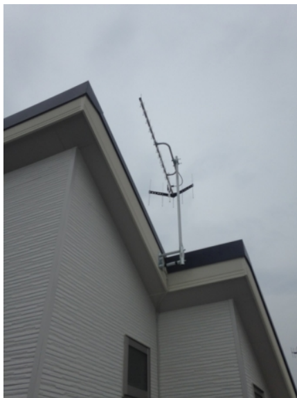
茅ヶ崎市香川 東栄住宅様物件 垂直偏波受信 壁面取付 地デジアンテナ工事
