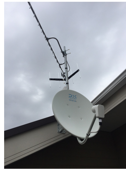
茅ヶ崎市平和町 破風板取付 八木式アンテナとBS/CSアンテナ工事
