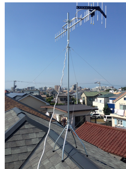
茅ヶ崎市東海岸北 サンケイホーム様物件 地デジアンテナ屋根上工事
