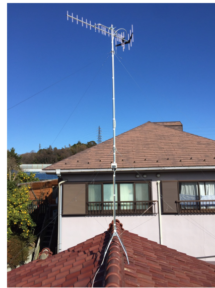
茅ヶ崎市赤羽根 屋根上設置 八木式アンテナ工事
