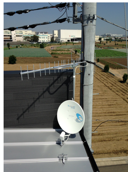
茅ヶ崎市中島 地デジアンテナとBSアンテナ工事
