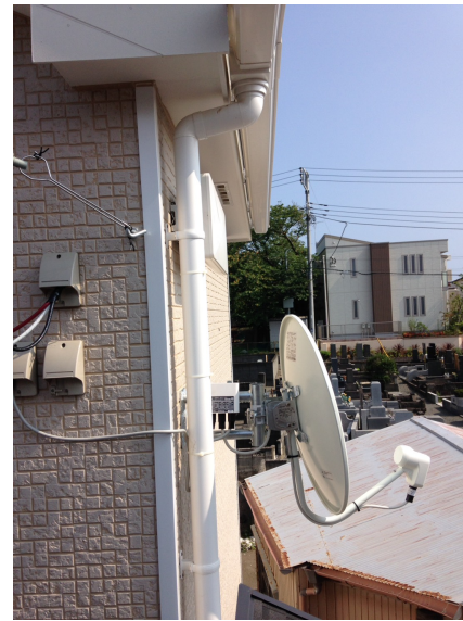
茅ヶ崎市十間坂 アーネストワン様物件 壁面取付 デザインアンテナとBSアンテナ工事
