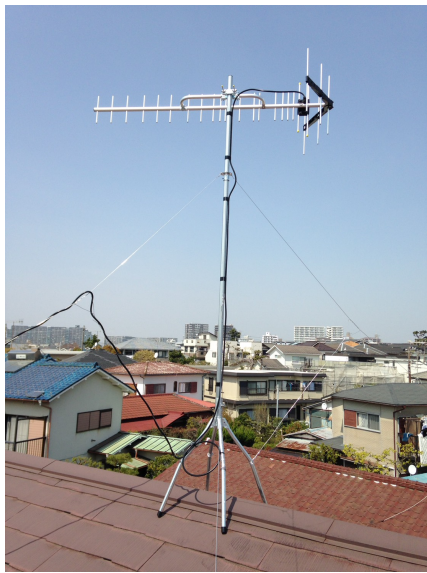
茅ヶ崎市共恵 屋根上設置 八木式アンテナ工事
