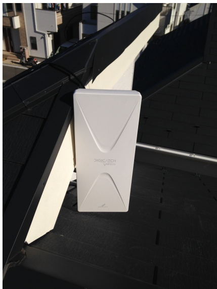
茅ヶ崎市松林 壁面取付 デザインアンテナ工事
