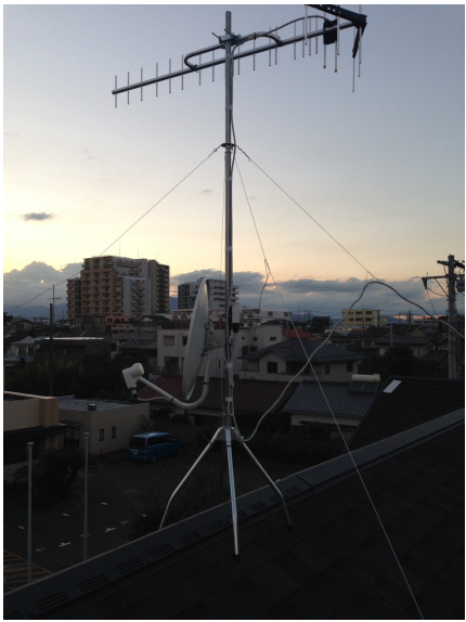
茅ヶ崎市本村 アーネストワン様物件 地デジアンテナとBSアンテナ屋根上工事件
