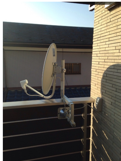
川崎市高津区久末 BSアンテナ挟み込み工事
