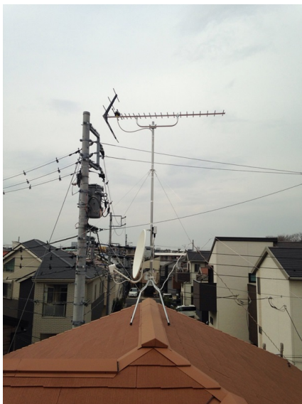
川崎市高津区諏訪 ミサワホーム様物件 地デジアンテナとBSアンテナ屋根上工事
