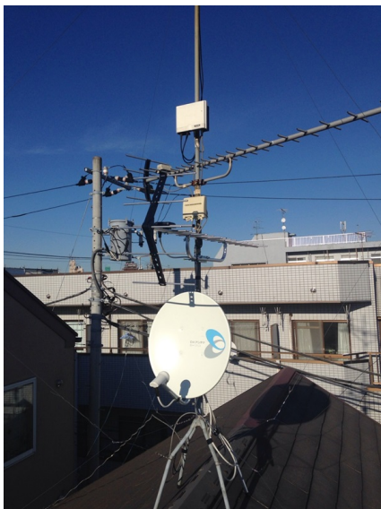
川崎市高津区千歳新町 地デジアンテナとBSアンテナ追加工事
