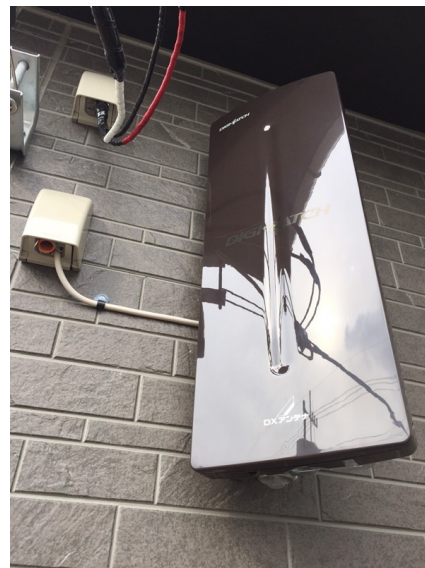
川崎市高津区北見方 壁面取付 デザインアンテナ工事
