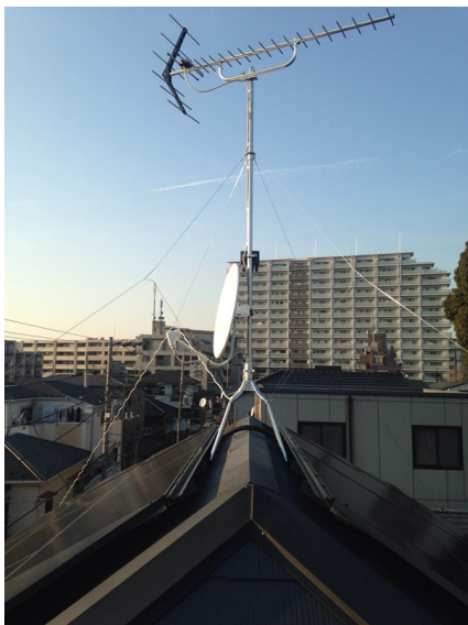
川崎市高津区二子 地デジアンテナとBSアンテナ屋根上工事
