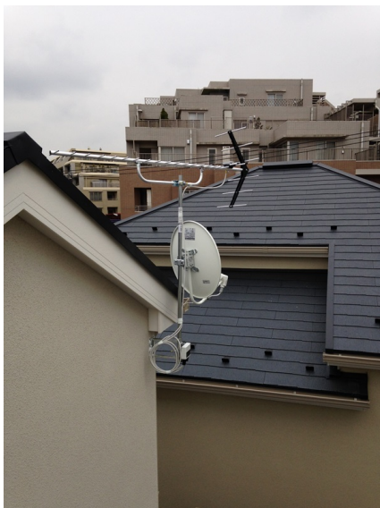
川崎市高津区梶ヶ谷 壁面取付 地デジアンテナとBSアンテナ工事
