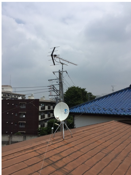
川崎市高津区末長 ミサワホーム様物件 地デジアンテナとBSアンテナ屋根上工事
