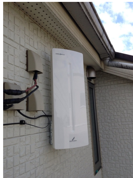
川崎市高津区上作延 壁面取付 デザインアンテナ工事
