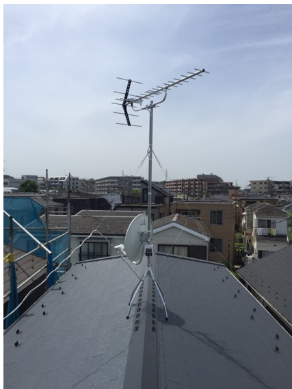
川崎市高津区溝口 オープンハウス様物件 地デジアンテナとBSアンテナ屋根上工事
