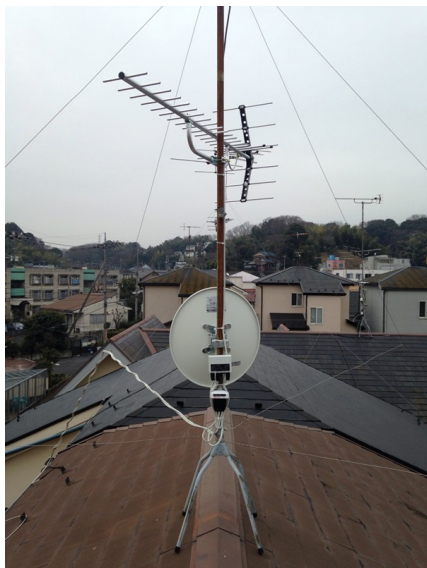
川崎市高津区久末 地デジアンテナとBSアンテナ追加工事
