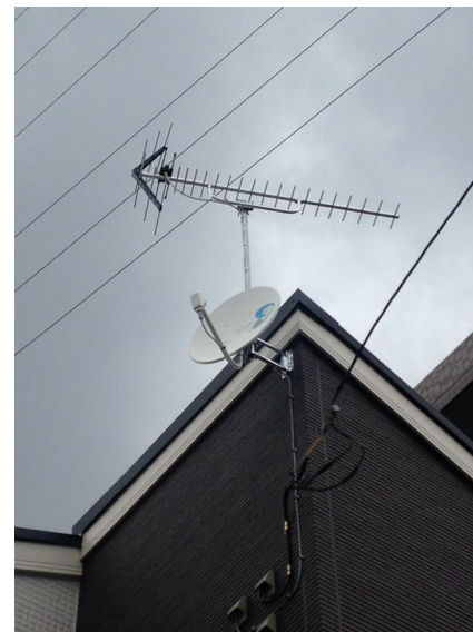
川崎市高津区子母口 プラザハウス様物件 壁面取付 地デジアンテナとBSアンテナ工事
