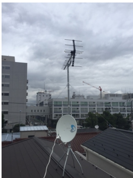
川崎市幸区小向西町 YAZAWA LUMBER様物件 地デジアンテナとBSアンテナ屋根上工事
