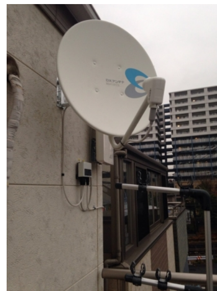
川崎市幸区塚越 壁面取付 BSアンテナ工事
