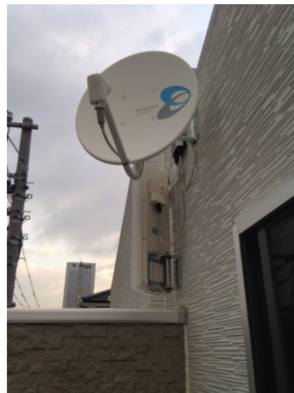
川崎市幸区仲野町 壁面取付 デザインアンテナとBSアンテナ工事
