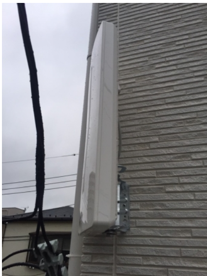
川崎市幸区幸町 フォーライフ様物件 壁面取付 デザインアンテナ工事
