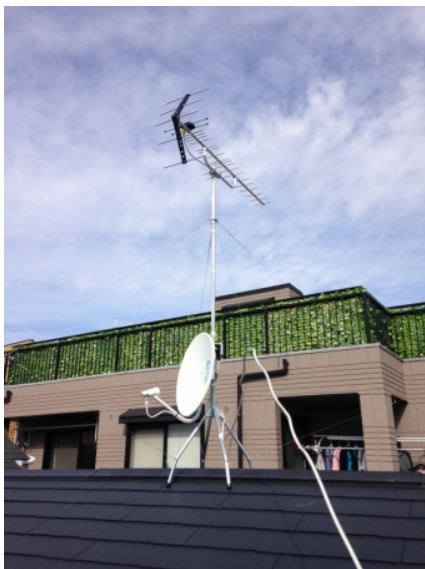
川崎市幸区戸出 地デジアンテナとBSアンテナ屋根上工事
