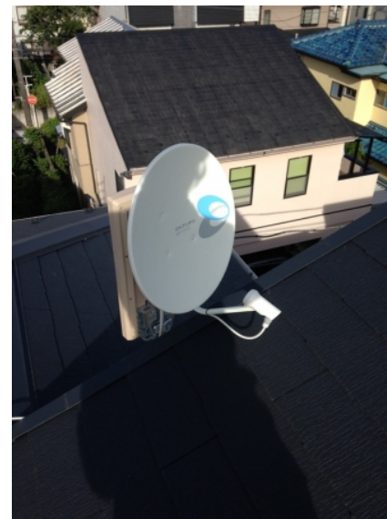
川崎市幸区古市場 壁面取付 デザインアンテナとBSアンテナ工事
