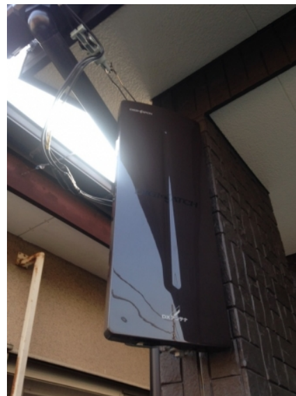
川崎市幸区古川町 アイフルホーム様物件 壁面取付 デザインアンテナ工事
