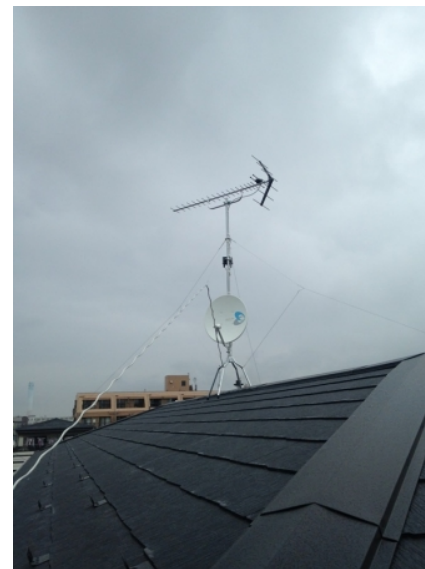
川崎市幸区古市場 ひかり建設様物件 地デジアンテナとBSアンテナ屋根上工事
