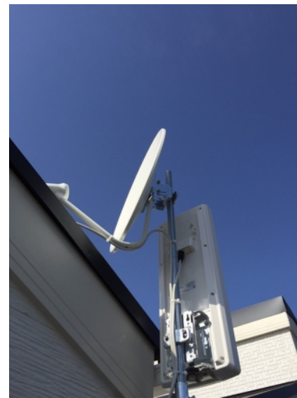
川崎市幸区南加瀬 一建設様物件 壁面取付 デザインアンテナとBSアンテナ工事
