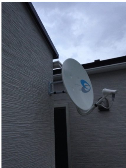
川崎市幸区南加瀬 三栄建築設計様物件 BSCSアンテナの壁面設置
