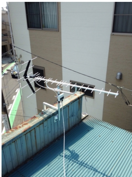
川崎市幸区小倉 地デジアンテナ挟み込み工事
