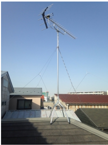
川崎市幸区塚越 地デジアンテナ屋根上工事
