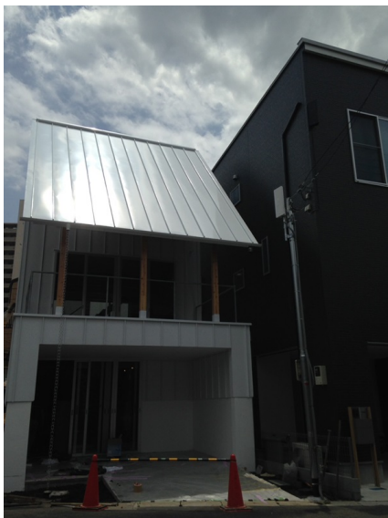
町田市小川 デザインアンテナ工事後の外観
