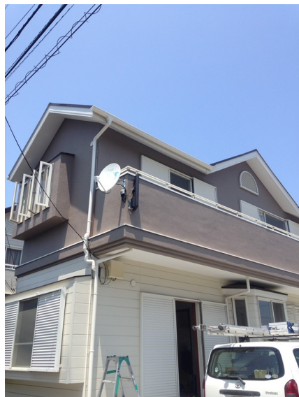
町田市本町田 デザインアンテナとBSアンテナ工事後の外観
