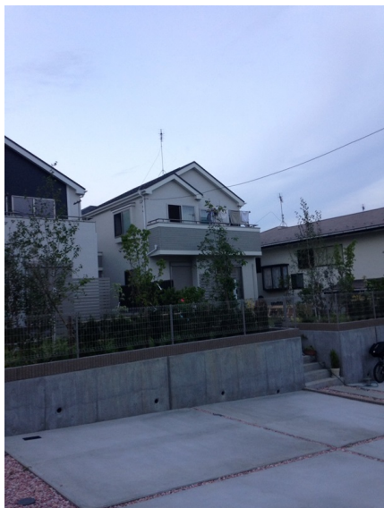
町田市成瀬 地デジアンテナ屋根上工事
