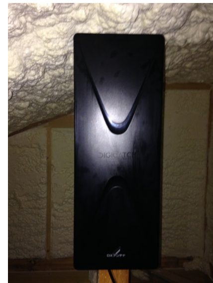
町田市小川 デザインアンテナ屋根裏設置
