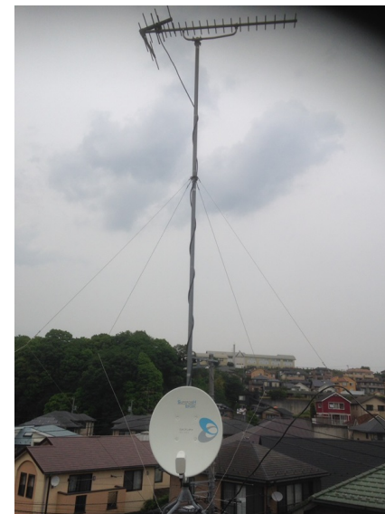
町田市真光寺 BSアンテナ追加工事後の外観
