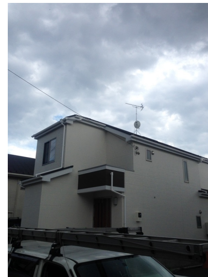
町田市鶴川 地デジアンテナとBSアンテナ屋根上工事
