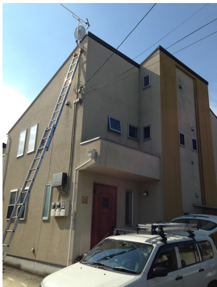
町田市南大谷 地デジアンテナとBSアンテナ工事後の外観
