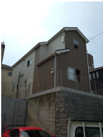
町田市野津田町 デザインアンテナ工事後の外観
