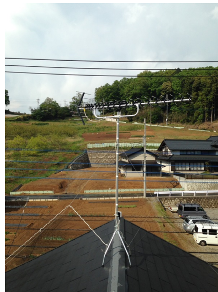
町田市小山田町 地デジアンテナ屋根上工事
