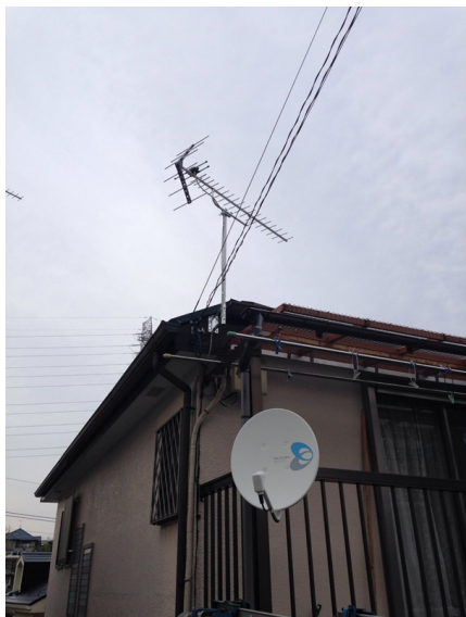
町田市金井 壁面取付 デザインアンテナ工事
