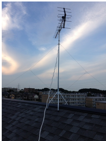
町田市南成瀬 地デジアンテナ工事
