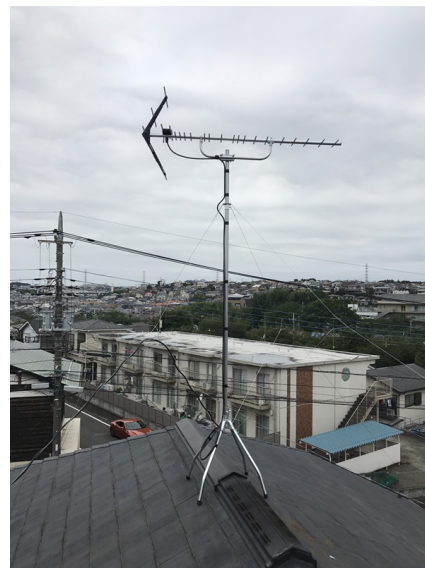
町田市本町田 デザインアンテナとBSアンテナ工事
