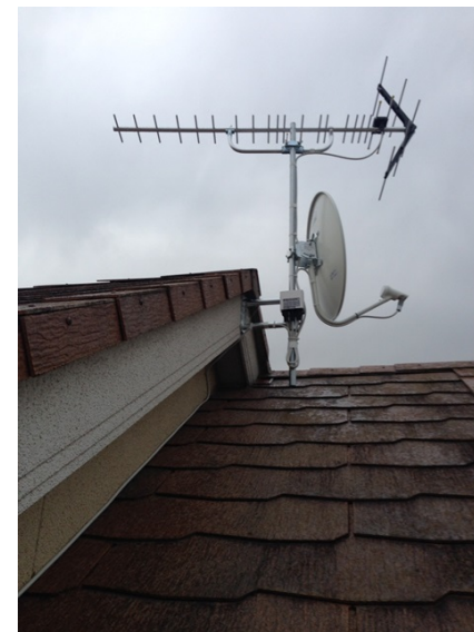
町田市金森 壁面取付 地デジアンテナとBSアンテナ工事
