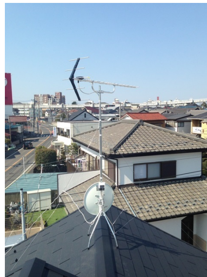
町田市本町 地デジアンテナとBSアンテナ屋根上工事
