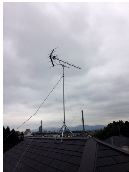
町田市小山町 IDホーム様物件 地デジアンテナ屋根上工事
