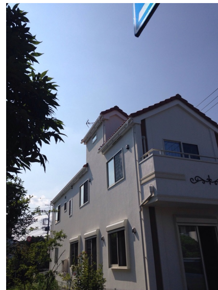
町田市三輪町 イーカム様物件 地デジアンテナ工事後の外観
