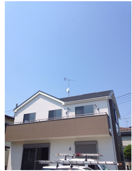
町田市高ヶ坂 サンケイホーム様物件 地デジアンテナとBSアンテナ工事後の外観
