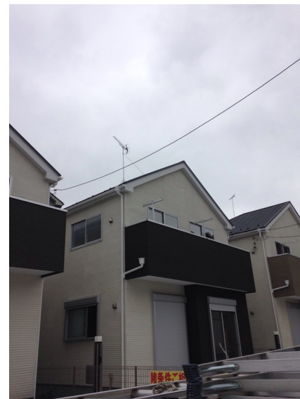
町田市小山町 IDホーム様物件 地デジアンテナ工事後の外観
