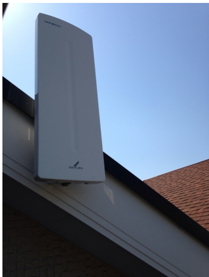
町田市根岸 創建様物件 壁面取付 デザインアンテナ工事
