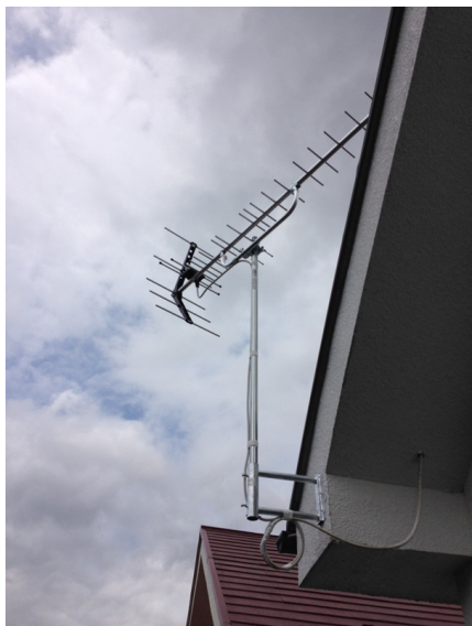
町田市三輪町 アーバンネクスト様物件 壁面取付 地デジアンテナ工事
