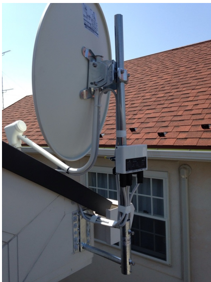
町田市根岸 創建様物件 壁面取付 BSアンテナ工事
