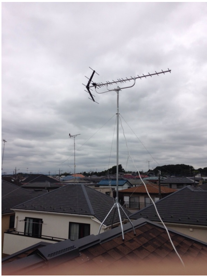
町田市能ヶ谷 サンケイホーム様物件 地デジアンテナ屋根上工事
