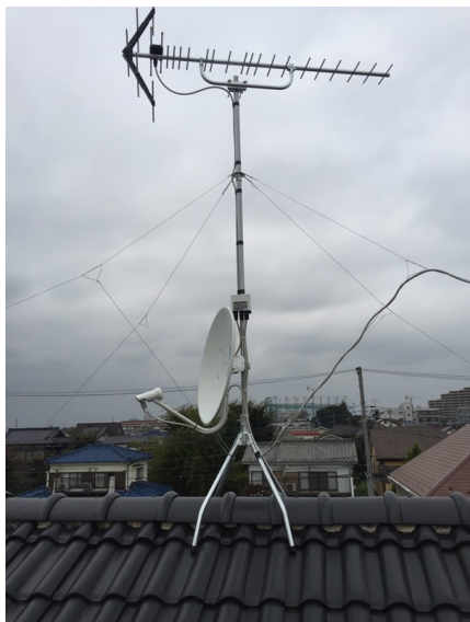
町田市鶴間 アイダ設計様物件 地デジアンテナとBSアンテナ屋根上工事
