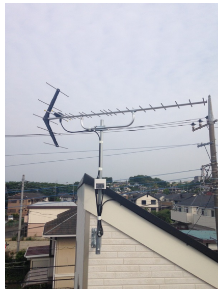
町田市小山町 サンケイホーム様物件 壁面取付 地デジアンテナ工事
