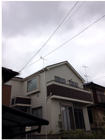
町田市能ヶ谷 サンケイホーム様物件 地デジアンテナ工事後の外観
