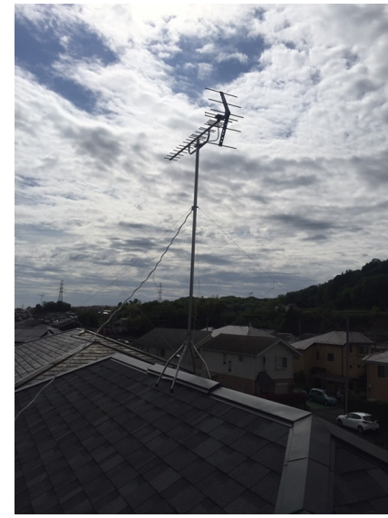
町田市野津田町 サンケイホーム様物件 地デジアンテナ屋根上工事
