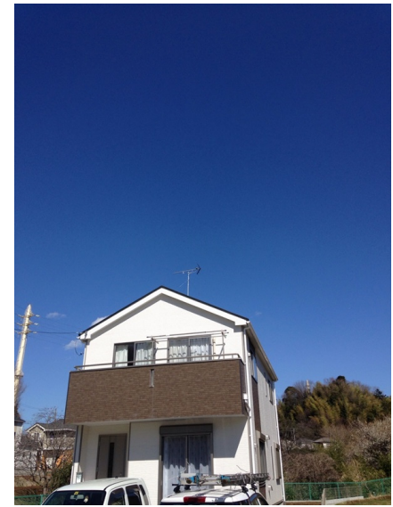
町田市図師町 アーネストワン様物件 地デジアンテナ工事後の外観
