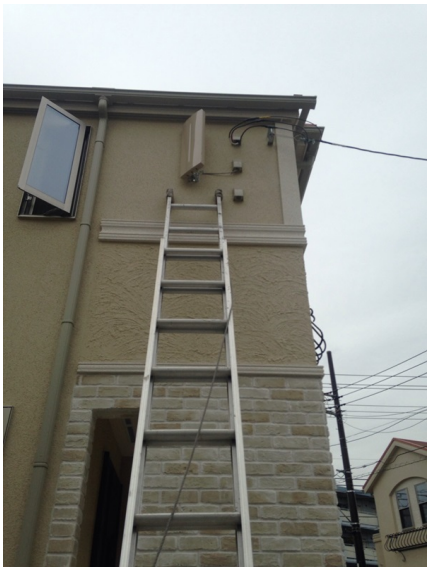
町田市成瀬が丘 ダイワハウス様物件 壁面取付 デザインアンテナ工事
