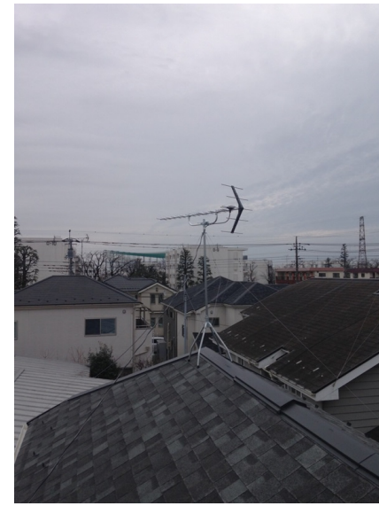
町田市木曽東 サンケイホーム様物件 地デジアンテナ屋根上工事
