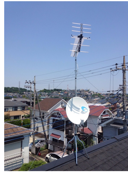
町田市高ヶ坂 サンケイホーム様物件 地デジアンテナとBSアンテナ屋根上工事
