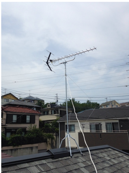
町田市本町田 飯田産業様物件 地デジアンテナ屋根上工事
