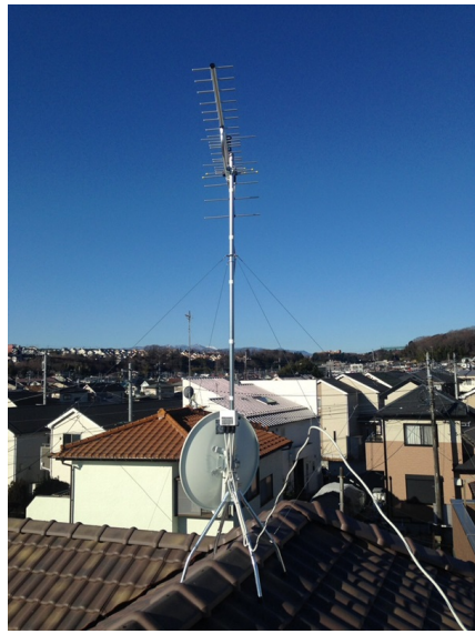
町田市野津田町 イーカム様物件 地デジアンテナとBSアンテナ屋根上工事
