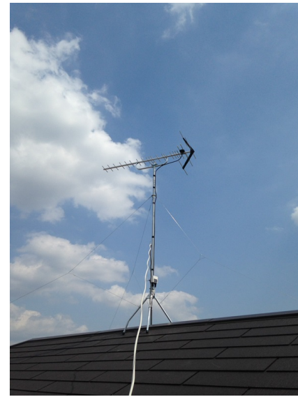
八王子市川口町 一建設様物件 地デジアンテナ屋根上工事
