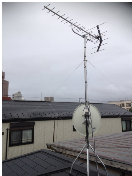
八王子市日吉町 東栄住宅様物件 地デジアンテナとBSアンテナ屋根上工事
