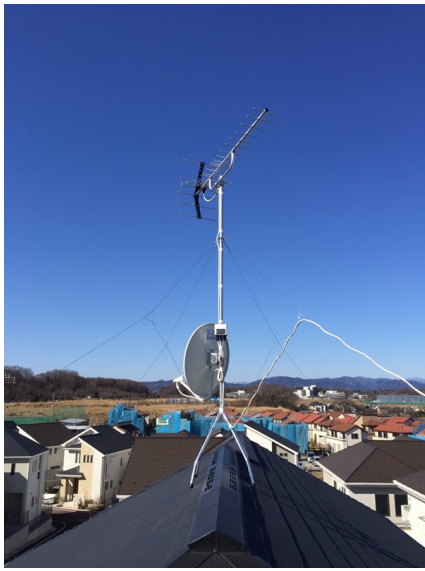
八王子市長房町 ハタノ木材様物件 BSアンテナ工事後の外観
