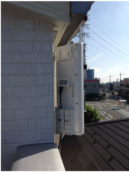
八王子市高倉町 共立ホーム様物件 壁面取付 デザインアンテナ工事
