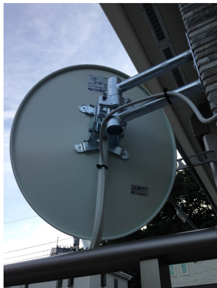
八王子市大塚 東亜建設様物件 壁面取付 BSアンテナ工事
