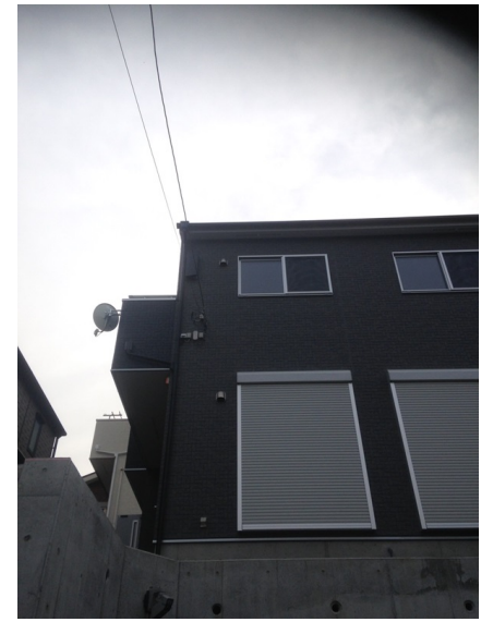
八王子市長房町 創和建设様物件 デザインアンテナとBSアンテナ工事後の外観
