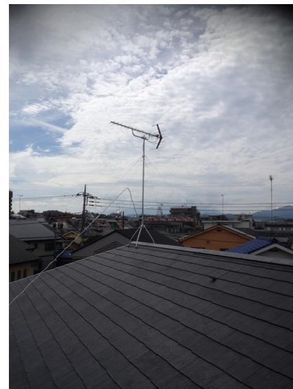
八王子市千人町 パナホーム様物件 地デジアンテナ屋根上工事
