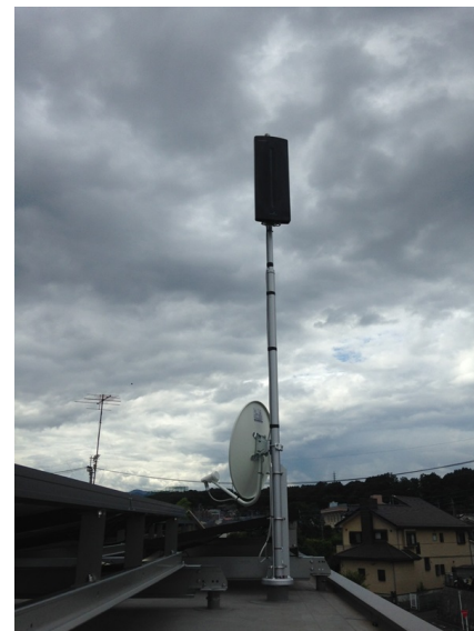
八王子市片倉町 旭化成様物件 デザインアンテナとBSアンテナ工事
