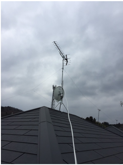
八王子市川口町 一建設様物件 地デジアンテナとBSアンテナ屋根上工事
