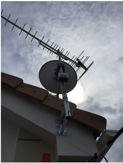
八王子市宇津木町 イーカム様物件 壁面取付 地デジアンテナとBSアンテナ工事
