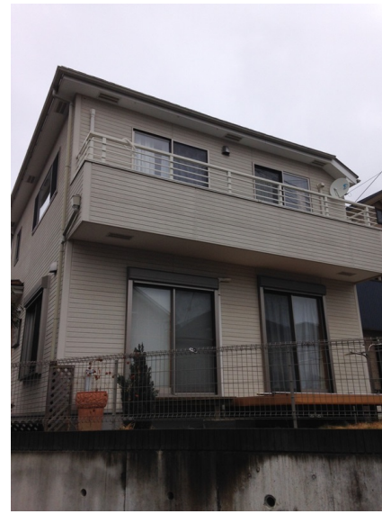
八王子市鎌水 東亜建設様物件 地デジアンテナとBSアンテナ屋根上工事
