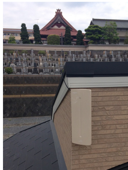
八王子市大和田町 住宅情報館様物件 壁面取付 デザインアンテナ工事
