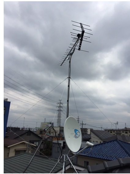
八王子市高倉町 タマホーム様物件 地デジアンテナとBSアンテナ屋根上工事
