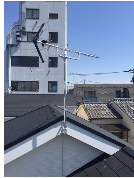
八王子市中野上町 アサヒ不動産様物件 壁面取付 地デジアンテナ工事
