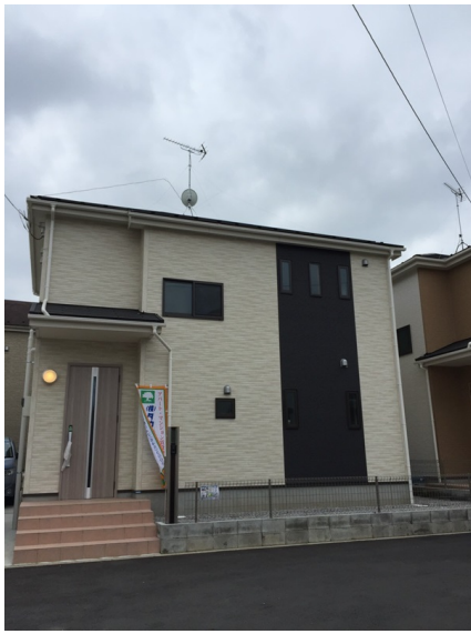
八王子市川口町 一建設様物件 地デジアンテナとBSアンテナ工事後の外観
