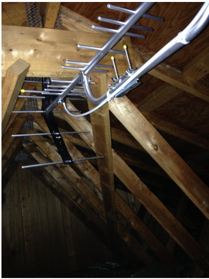
八王子市城山手 三井ホーム様物件 地デジアンテナ屋根裏工事
