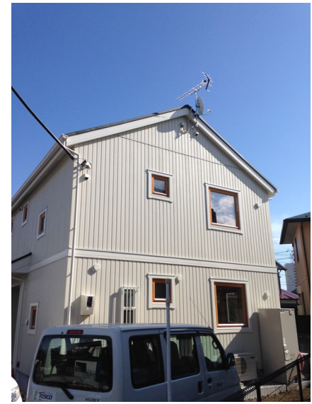
八王子市廿里町 ジューテックホーム様物件 地デジアンテナとBSアンテナ工事後の外観
