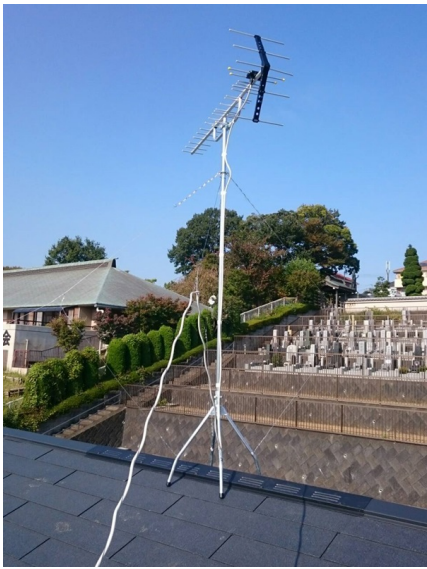
八王子市大和田町 住宅情報館様物件 地デジアンテナ屋根上工事
