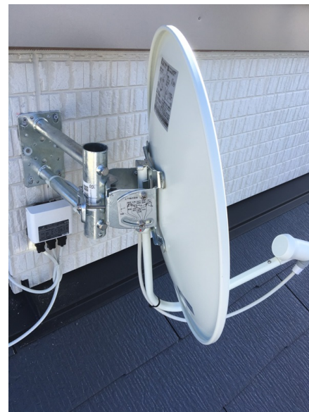
調布市深大寺 トヨタホーム様物件 壁面取付 BSアンテナ工事
