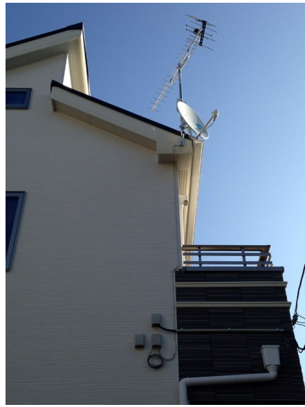
調布市富士見町 壁面取付 地デジアンテナとBSアンテナ工事
