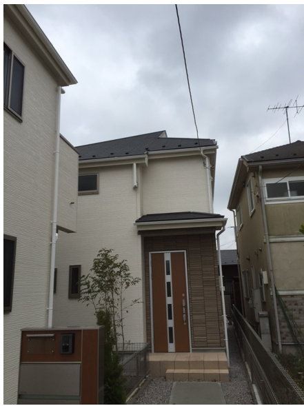
調布市深大寺北町 東栄住宅様物件 デザインアンテナ工事後の外観
