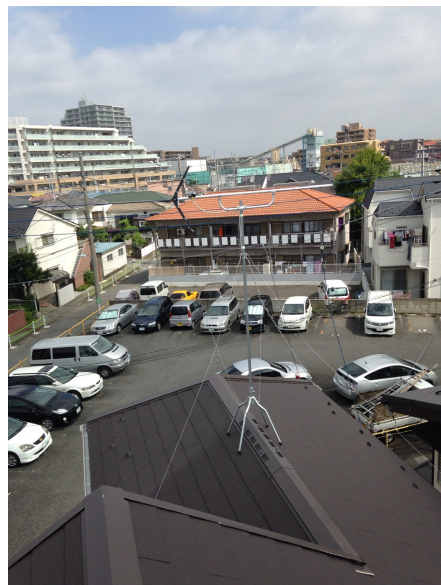
調布市多摩川 地デジアンテナ屋根上工事
