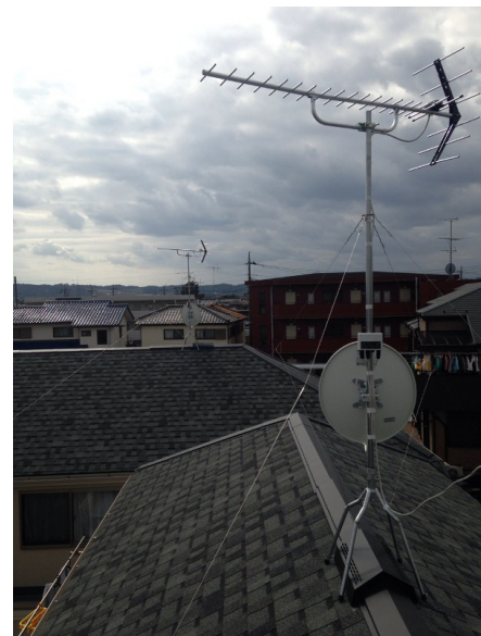
調布市飛田給 地デジアンテナとBSアンテナ屋根 上工事
