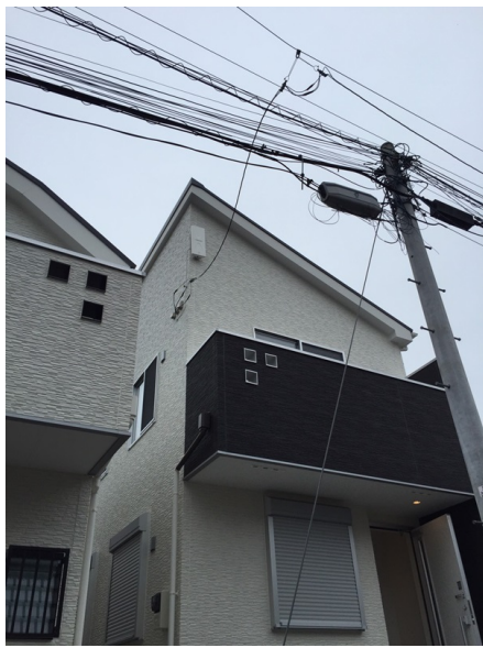
調布市緑ヶ丘 マイライフプランニング様物件 デザインアンテナ工事後の外観
