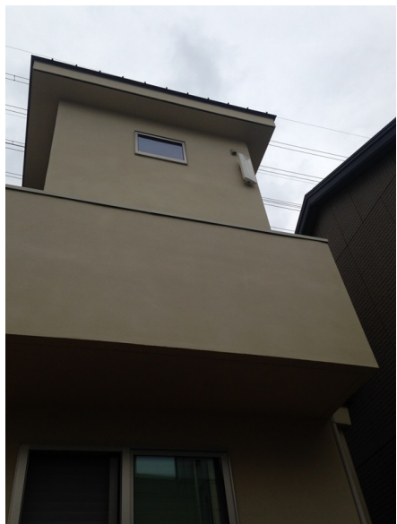
調布市緑ヶ丘 デザインアンテナ工事後の外観
