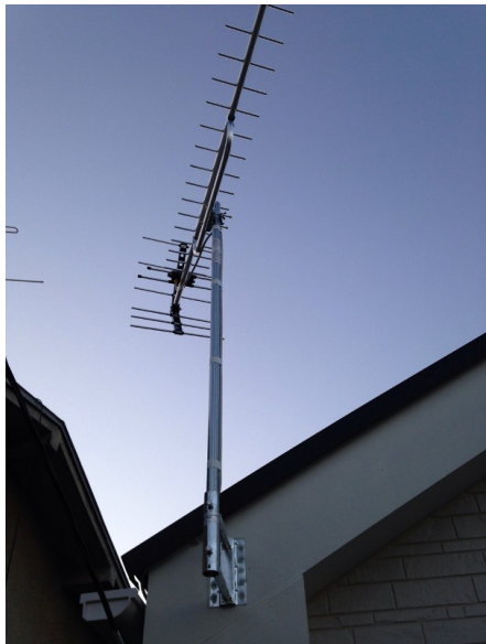
調布市深大寺元町 壁面取付 地デジアンテナ工事
