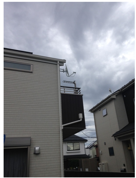
調布市小島町 誠賀建設様物件 B S アンテナ工事後の外観
