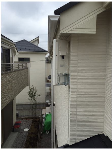
調布市深大寺北町 東栄住宅様物件 壁面取付 デザインアンテナ工事
