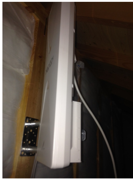
調布市深大寺南 トヨタホーム様物件 デザインアンテナ屋根裏工事
