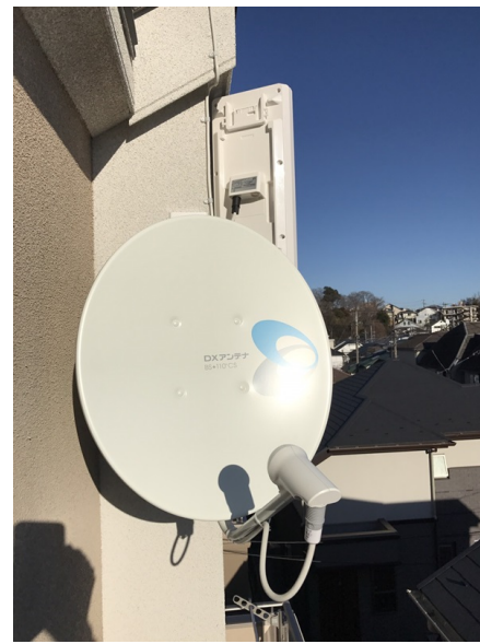
調布市東つつじヶ丘 フージャース様物件 壁面取付 デザインアンテナとBSアンテナ工事
