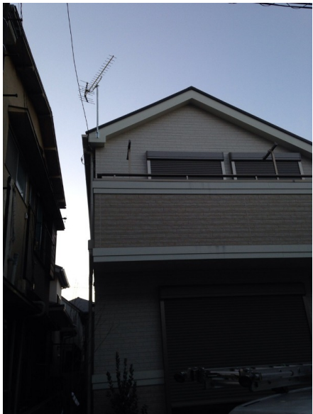
調布市入間町 ブースター交換工事
