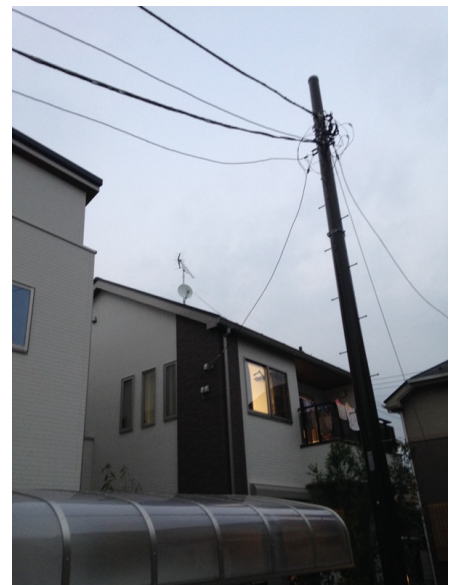
調布市深大寺南町 トヨタホーム様物件 地デジアンテナとB S アンテナ工事後の外観
