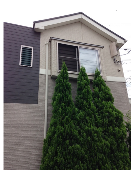
調布市深大寺北町 デザインアンテナ工事後の外観
