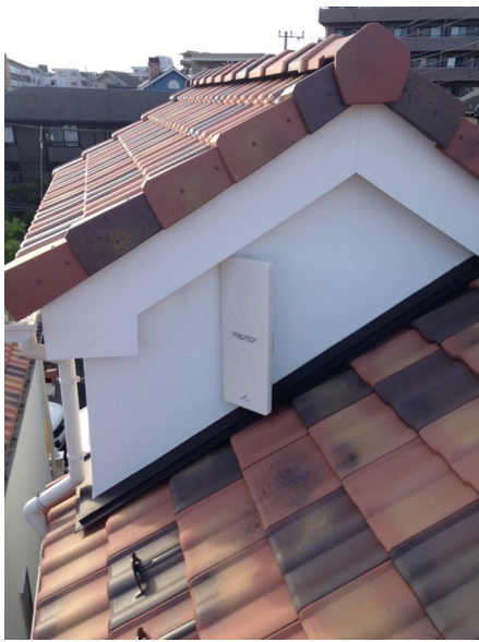
調布市国領町 イーカム様物件 壁面取付 デザインアンテナ工事
