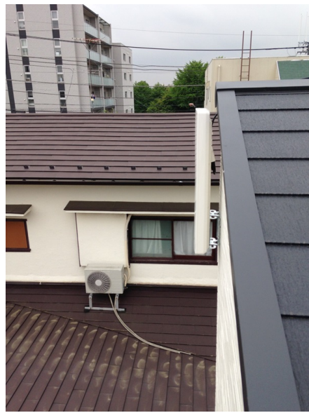
調布市国領町 ホークワン様物件 壁面取付 デザインアンテナ工事
