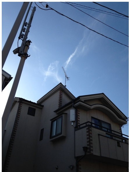
調布市小島町 ベルウッドホーム様物件 地デジアンテナ工事後の外観
