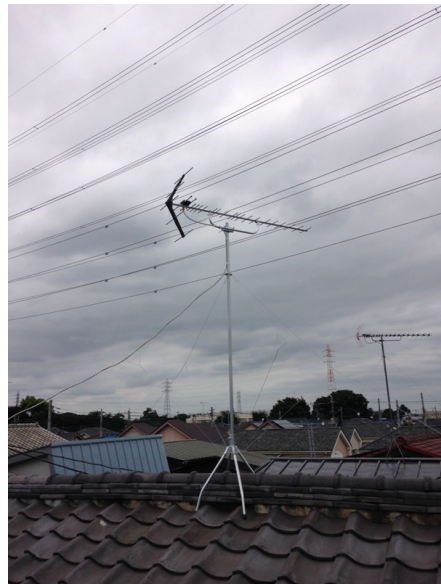
調布市深大寺北町 地デジアンテナ屋根上工事
