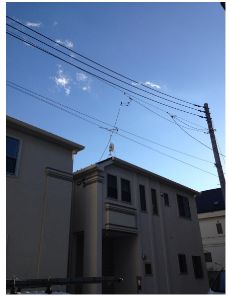
調布市上石原 地デジアンテナとBSアンテナ工事後の外観
