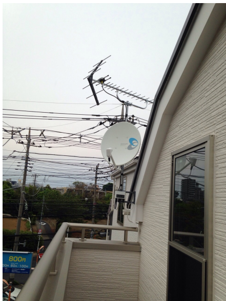
調布市布田 壁面取付 地デジアンテナとBSアンテナ工事
