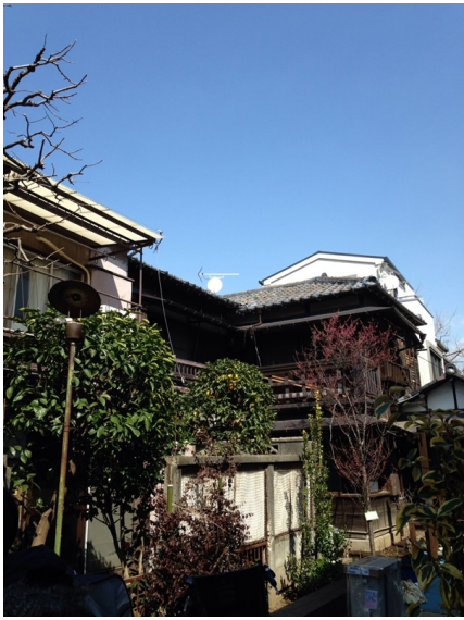
台東区西浅草 BSアンテナ工事後の外観
