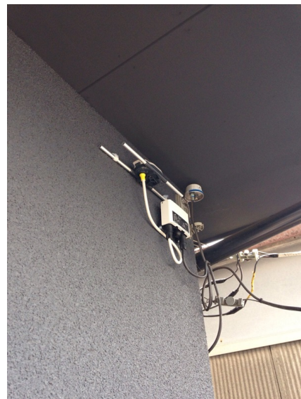
台東区千束 ポラス様物件 壁面取付 地デジアンテナ工事
