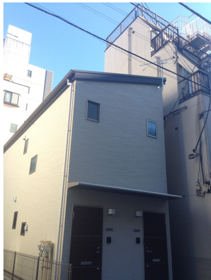
台東区台東 地デジアンテナ工事後の外観
