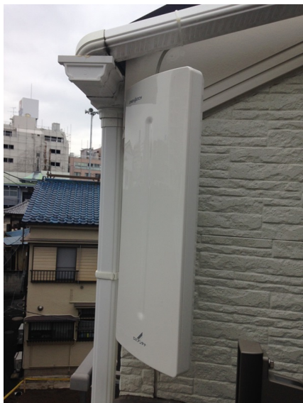
台東区根岸 東建ホームズ様物件 壁面取付 デザインアンテナ工事
