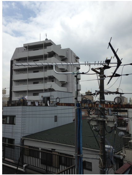
台東区日本堤 地デジアンテナ工事
