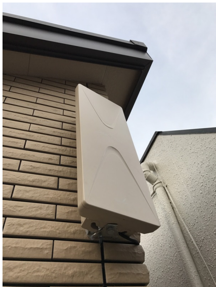
台東区浅草 一条工務店様物件 壁面取付 デザインアンテナ工事
