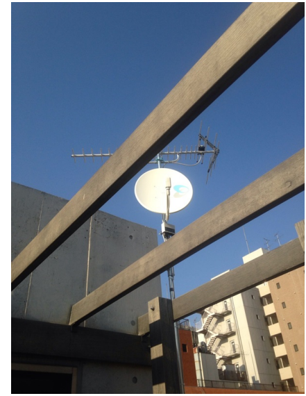
台東区寿 BSアンテナ追加工事後の外観
