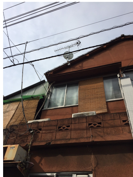
台東区日本堤 地デジアンテナとBSアンテナ工事
