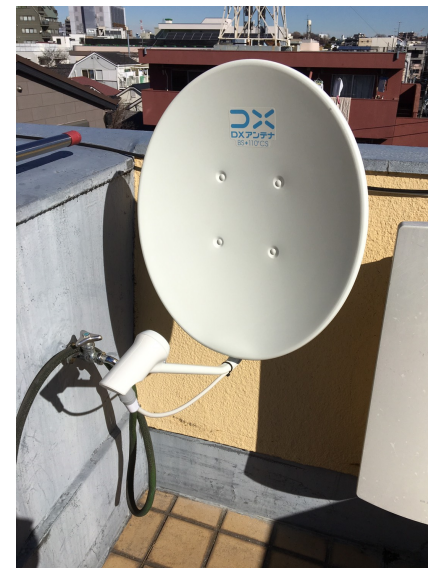
台東区谷中 壁面取付 BSアンテナ工事
