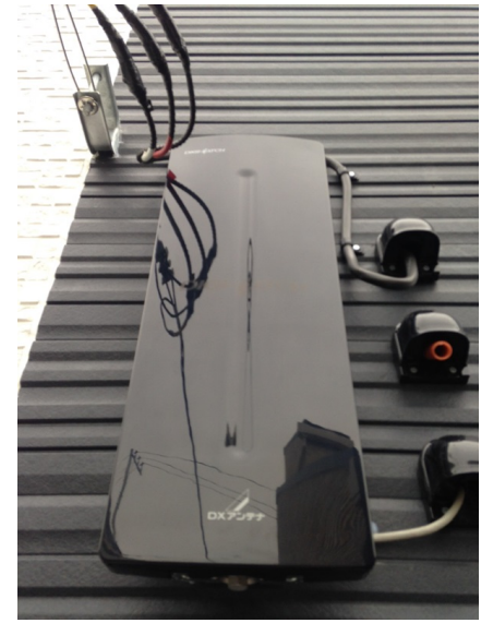
世田谷区宮坂 オープンハウス様物件 壁面取付 デザインアンテナ工事
