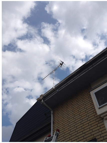
世田谷区上野毛 エアスティール様物件 壁面取付 地デジアンテナ工事
