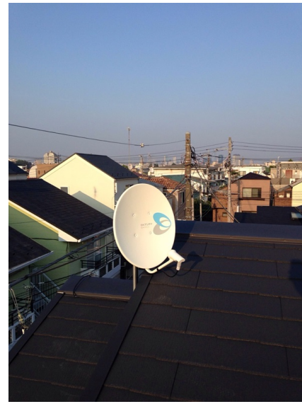
世田谷区梅丘 オープンハウス様物件 壁面取付 BSアンテナ工事
