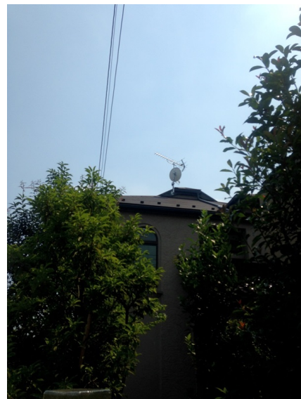
世田谷区上祖師谷 津田建設様物件 地デジアンテナとBSアンテナ工事後の外観
