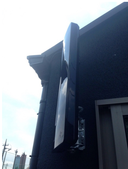
世田谷区三宿 イトーピア様物件 壁面取付 デザインアンテナ工事
