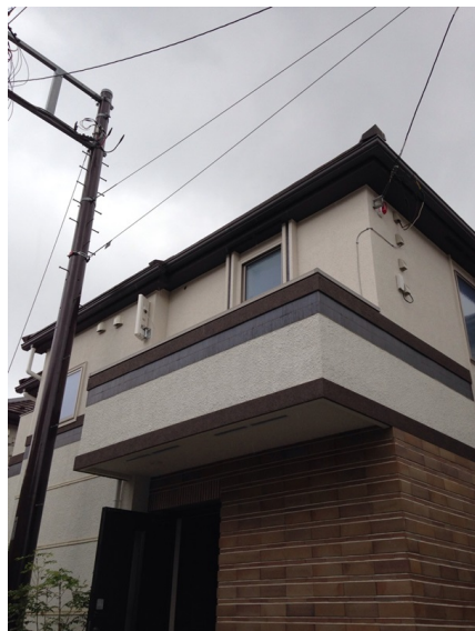
世田谷区上用賀 東急建設様物件 デザインアンテナ工事後の外観
