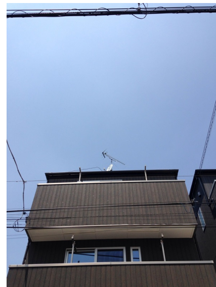
世田谷区世田谷 大成有楽不動産様物件 地デジアンテナとBSアンテナ工事後の外観
