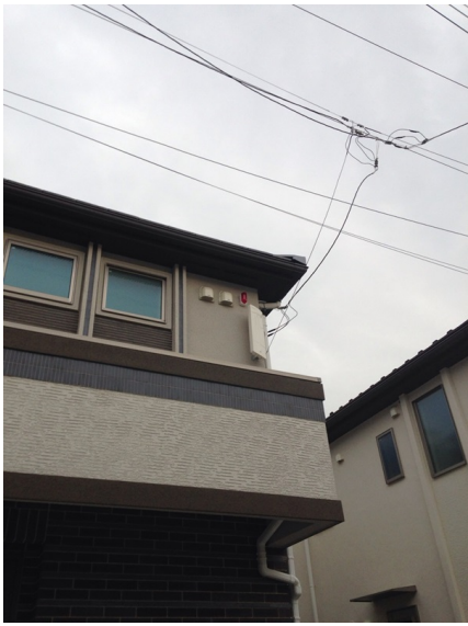
世田谷区代田 三栄建築設計様物件 壁面取付 BSアンテナ工事後の外観
