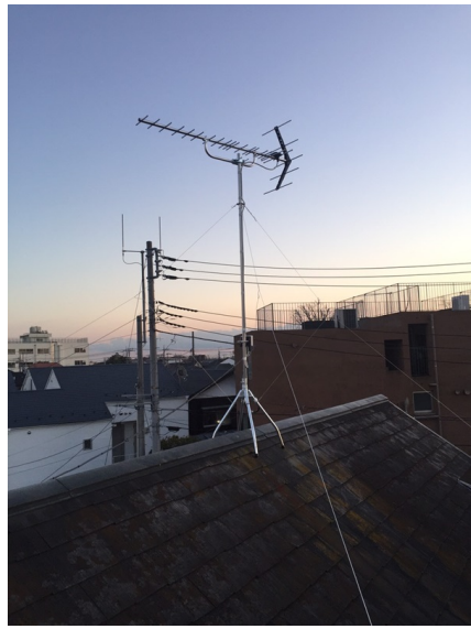
世田谷区桜上水 東急住宅リース様物件 地デジアンテナ屋根上工事
