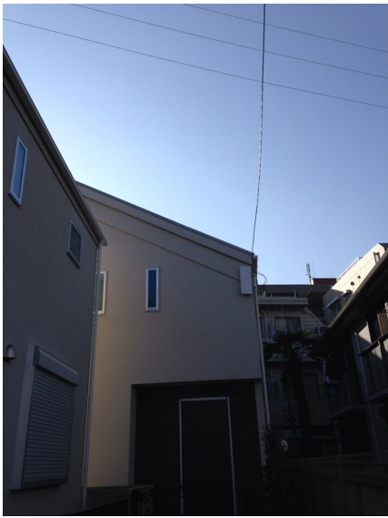
世田谷区上祖師谷 アイムユニバース様物件 デザインアンテナ工事後の外観
