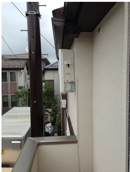
世田谷区上用賀 東急建設様物件 壁面取付 デザインアンテナ工事
