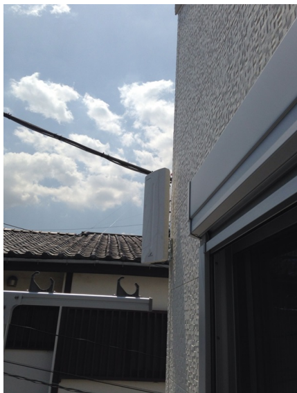
世田谷区代沢 アサカワホーム様物件 壁面取付 デザインアンテナ工事
