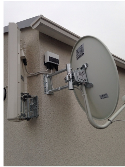
世田谷区船橋 シティートータルプラン様物件 デザインアンテナとBSアンテナ工事後の外観
