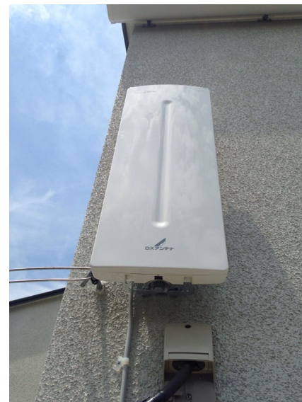
世田谷区八幡山 東京組様物件 デザインアンテナ取付金具
