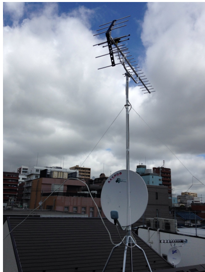
大田区池上 地デジアンテナとBSアンテナ屋根上工事
