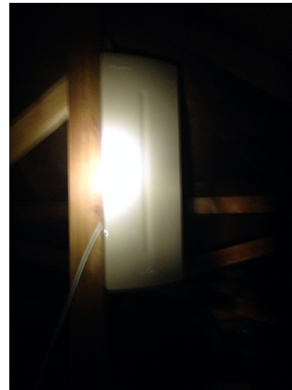
大田区田園調布 デザインアンテナ屋根裏工事
