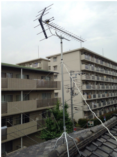
大田区鶴の木 地デジアンテナ工事 屋根上工事
