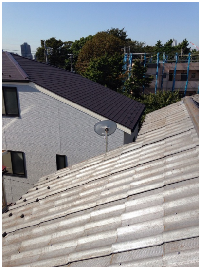
大田区南久が原 アンテナ取り替え前
