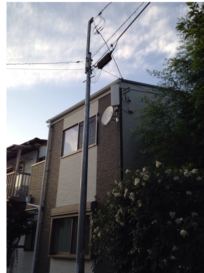
大田区上池台 壁面取付 地デジアンテナとBSアンテナ工事後の外観
