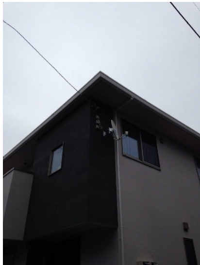
大田区千鳥 壁面取付 BSアンテナ工事後の外観
