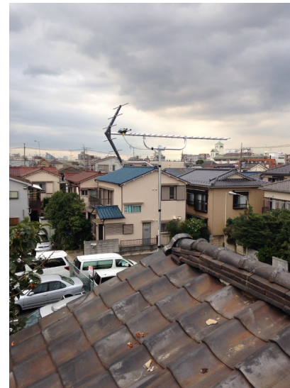
大田区上池台 地デジアンテナとBSアンテナ屋 根上工事
