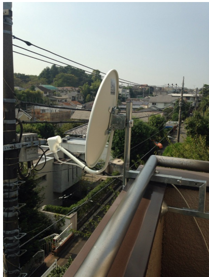
大田区田園調布 BSアンテナ挟み込み工事
