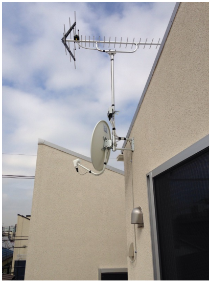
大田区中央 壁面取付 地デジアンテナとBSアンテナ工事
