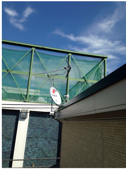
大田区東矢口 壁面取付 地デジアンテナとBSアンテナ工事
