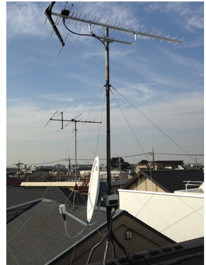
大田区蒲田本町 壁面取付 デザインアンテナ 工事
