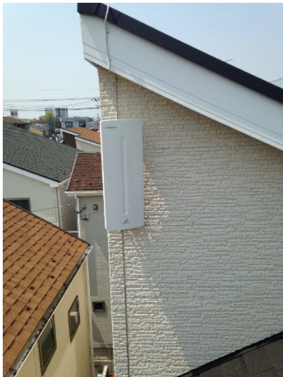
大田区下丸子 壁面取付 デザインアンテナ工事
