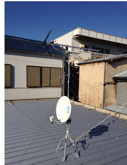
大田区羽田 壁面取付 地デジアンテナ工事
