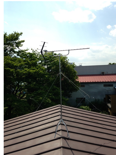
大田区西嶺町 地デジアンテナ屋根上工事
