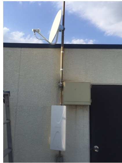
板橋区赤塚 デザインアンテナとBSアンテナ追加工事
