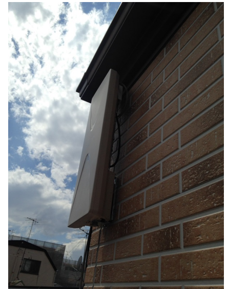
板橋区清水町 壁面取付 デザインアンテナ工事
