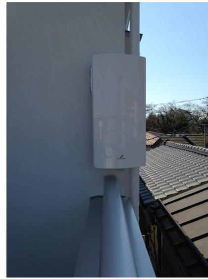
板橋区加賀 壁面取付 デザインアンテナ工事
