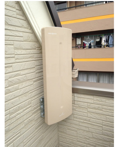
板橋区志村 壁面取付 デザインアンテナ工事
