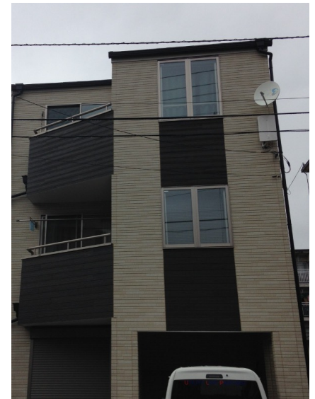
板橋区前野町 BSアンテナ追加工事後の外観
