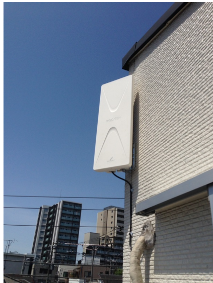
板橋区大谷口 壁面取付 デザインアンテナ工事
