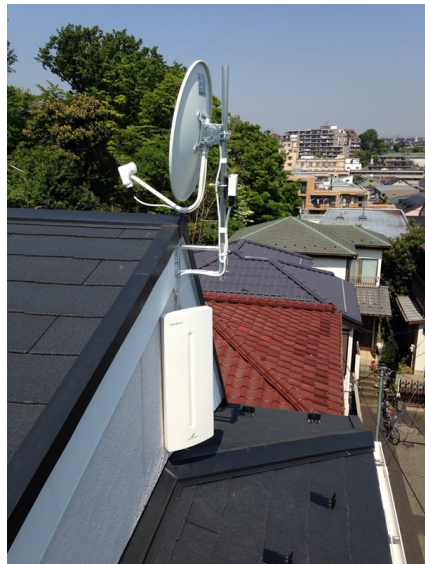
板橋区成増 壁面取付 デザインアンテナとBSアンテナ工事
