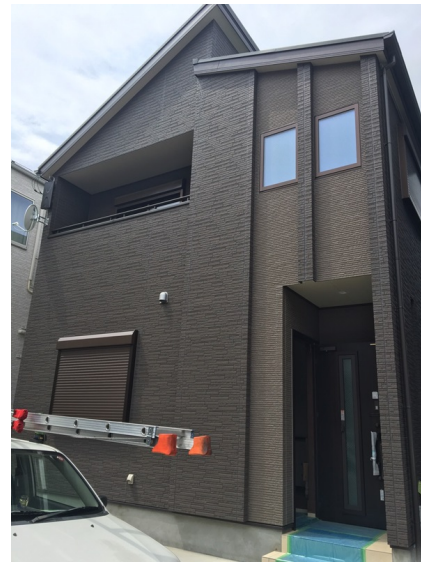
橋区栄町 デザインアンテナとBSアンテナ工事後の外観
