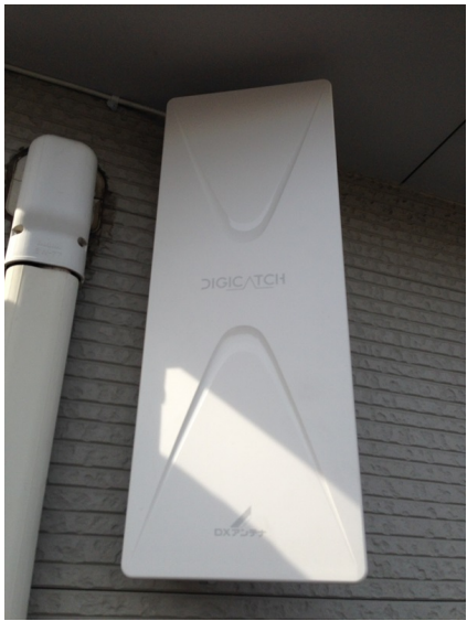
板橋区相生町 壁面取付 デザインアンテナ工事
