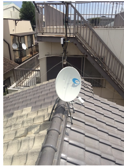
板橋区小茂根 BSアンテナ追加工事
