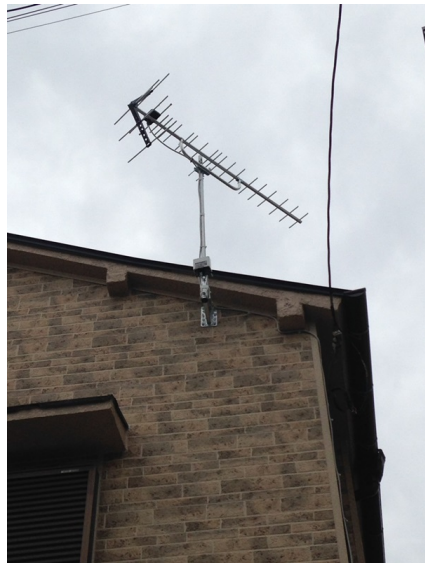
板橋区徳丸 壁面取付 地デジアンテナ工事
