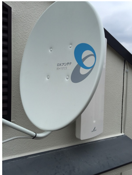
板橋区本町 壁面取付 デザインアンテナとBSアンテナ工事
