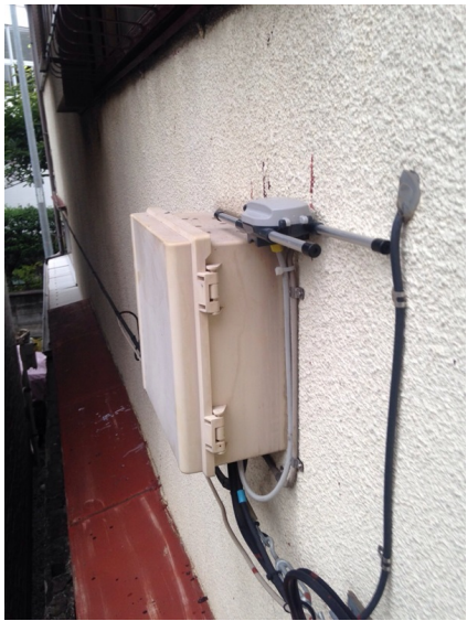
板橋区本町 壁面取付 地デジアンテナ工事
