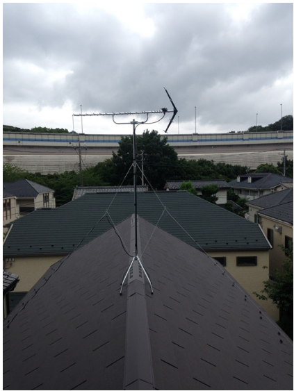
板橋区高島平 地デジアンテナ屋根上工事
