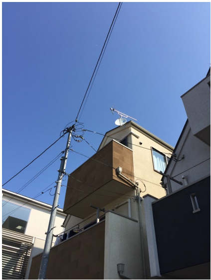
板橋区中台 地デジアンテナとBSアンテナ工事後の外観
