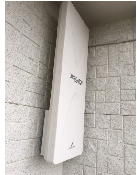
板橋区中台 壁面取付 デザインアンテナ工事
