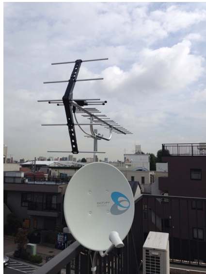
板橋区向原 フェンス取付 地デジアンテナとBSアンテナ工 事
