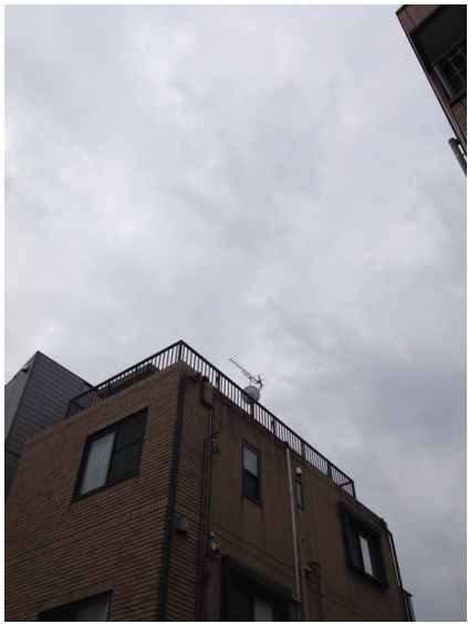
板橋区向原 地デジアンテナとBSアンテナ工後の外観
