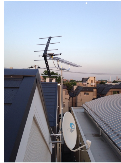
板橋区桜川 壁面取付 地デジアンテナとBSアンテナ工事
