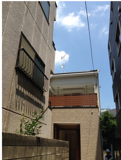
板橋区徳丸 地デジアンテナとBSアンテナ工事後の外観
