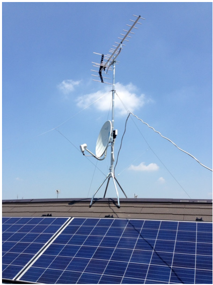
板橋区徳丸 地デジアンテナとBSアンテナ屋根上工事
