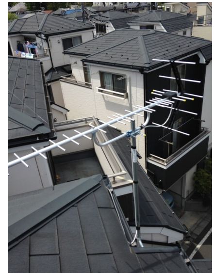
板橋区四葉 壁面取付 地デジアンテナ工事
