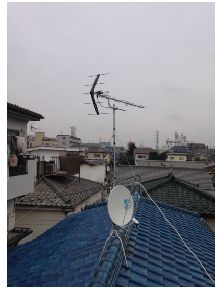
板橋区赤塚 地デジアンテナとBSアンテナ屋 根上工事
