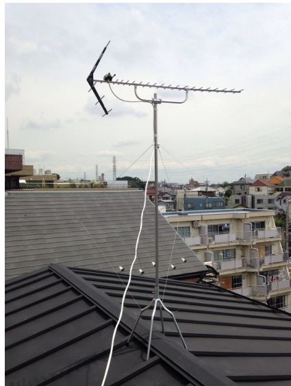
板橋区徳丸 地デジアンテナ屋根上工事
