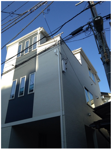
板橋区東坂下 飯田産業様物件 地デジアンテナ工事後の外観
