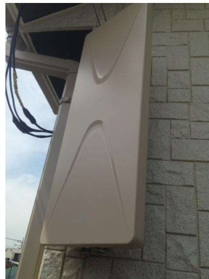
八潮市南後谷 壁面取付 デザインアンテナ工事
