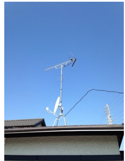
八潮市緑町 地デジアンテナとBSアンテナ屋根上工事
