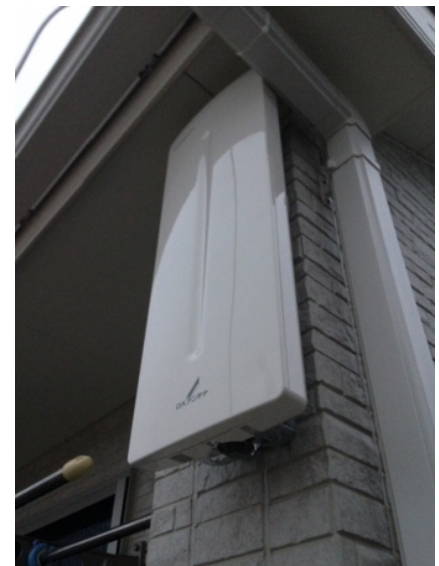
鶴ヶ島市藤金 壁面取付 デザインアンテナ工事
