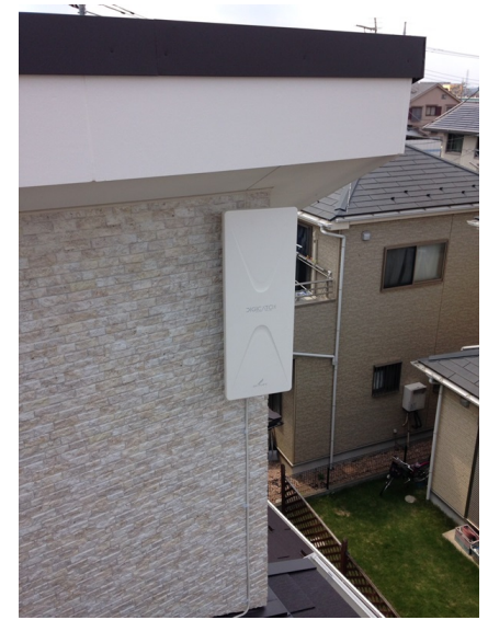
所沢市上新井 住協建設様物件 壁面取付 デザインアンテナ工事
