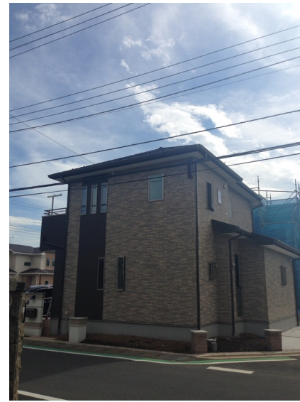
所沢市下富 住協建設様物件 デザインアンテナ工事後の外観
