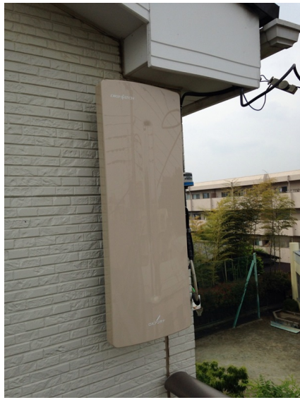
所沢市小手指 壁面取付 デザインアンテナ工 事
