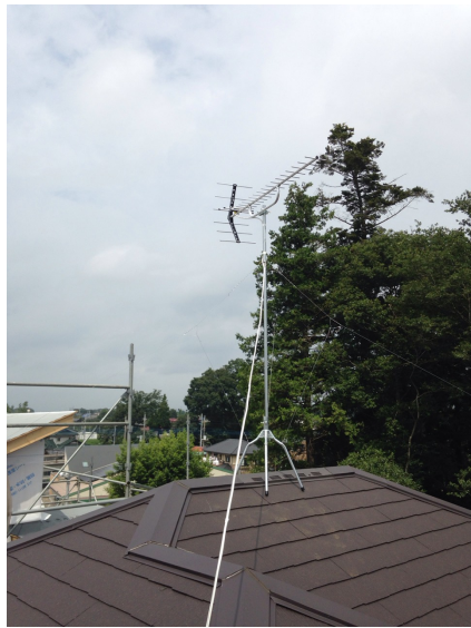
所沢市小手指南 地デジアンテナ屋根上工事
