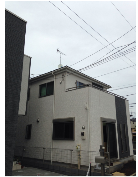
所沢市北中 地デジアンテナとBSアンテナ工事 後の外観
