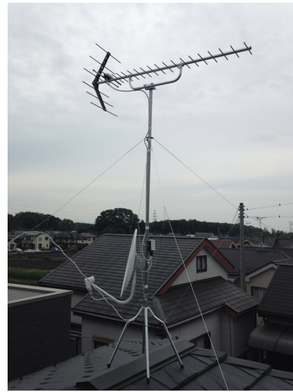
所沢市北中 地デジアンテナとBSアンテナ屋根 上工事
