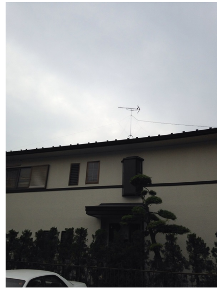
所沢市緑町 地デジアンテナ工事後の外観
