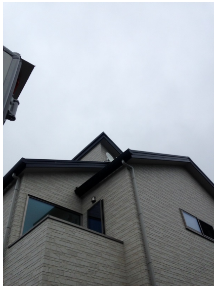
所沢市林 近藤建設様物件 壁面取付 BSアンテナ工事
