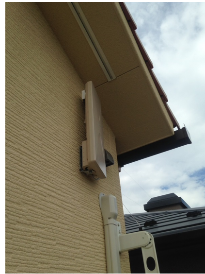
所沢市花園 一条工務店様物件 デザインアンテナ工事後の外観
