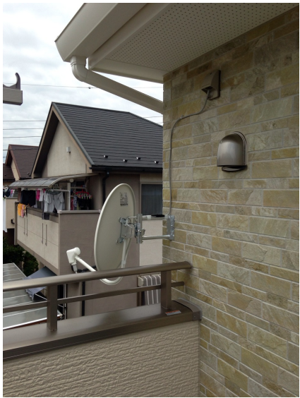
所沢市向陽町 壁面取付 BSアンテナ工事
