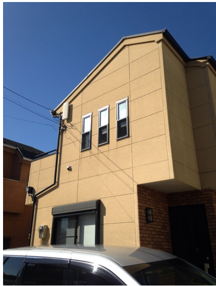
所沢市緑町 地デジアンテナ屋根上工事
