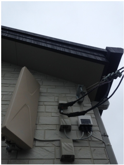
所沢市林 近藤建設様物件 壁面取付 デザインアンテナ工事
