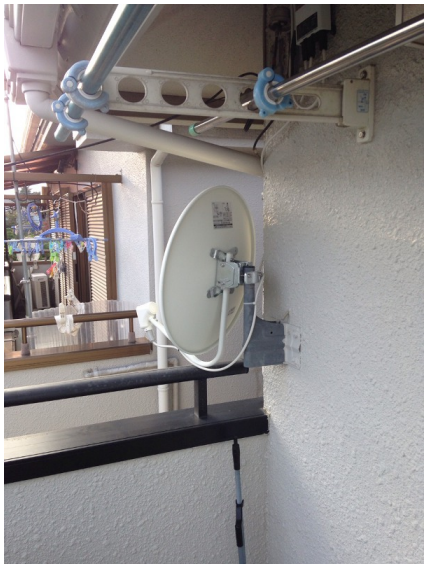
所沢市小手指元町 壁面取付 BSアンテナ工事
