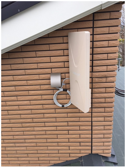
所沢市久米 飯田産業様物件 壁面取付 デザインアンテナ工事
