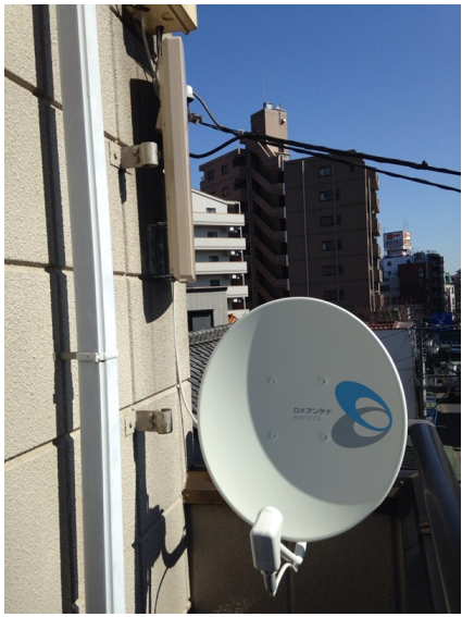
沢市西所沢 デザインアンテナとBSアンテナ工 事
