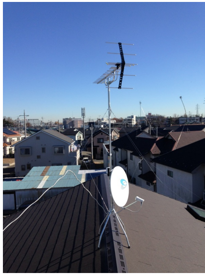
所沢市小手指南 地デジアンテナ工事後の外観
