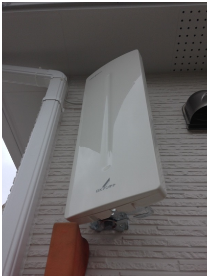
所沢市小手指南 アップルホーム様物件 壁面取付 デザインアンテナ工事
