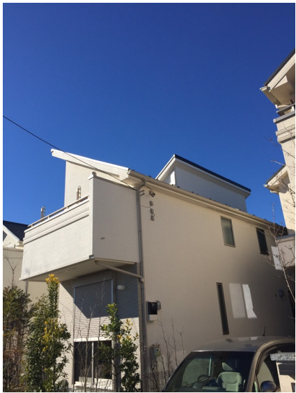
所沢市上新井 東急建設様物件 デザインアンテナ工事後の外観
