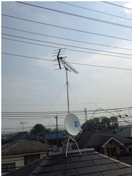
所沢市北岩岡 住協建設様物件 地デジアンテナとBSアンテナ屋根上工事
