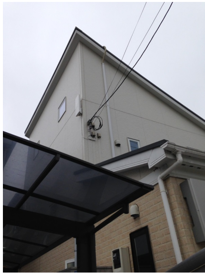
所沢市秋津町 デザインアンテナ工事後の外観
