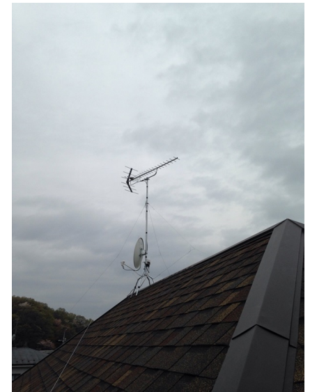
所沢市上山口 山口企画設計様物件 地デジアンテナとBSアンテナ屋根上工事
