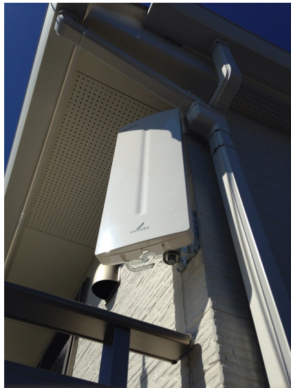
所沢市花園 住協建設様物件 壁面取付 デザインアンテナ工事
