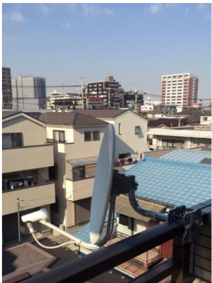
戸田市中町 ベランダ取付 BSアンテナ工事
