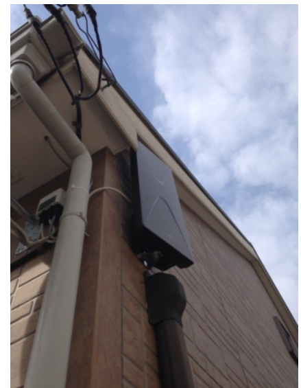
戸田市笹目 壁面取付 デザインアンテナ工事
