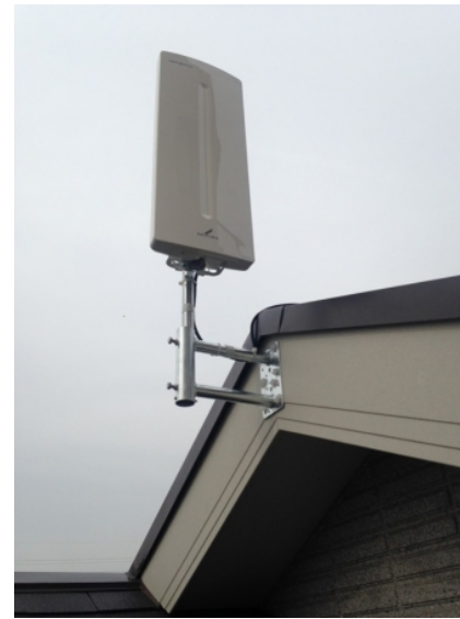
戸田市新曽 大宝建設様物件 壁面取付 デザインアンテナ工事
