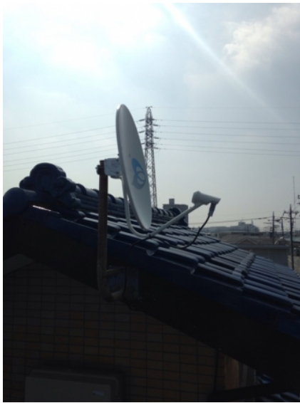
戸田市笹目南町 壁面取付 BSアンテナ工事
