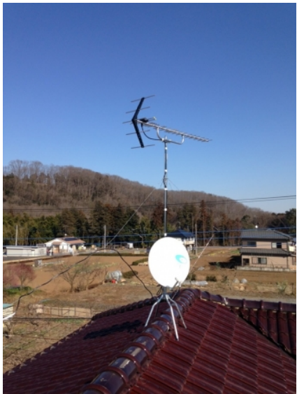
飯能市岩淵 地デジアンテナとBSアンテナ屋根上工事
