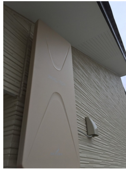
飯能市双柳 壁面取付 デザインアンテナ工事
