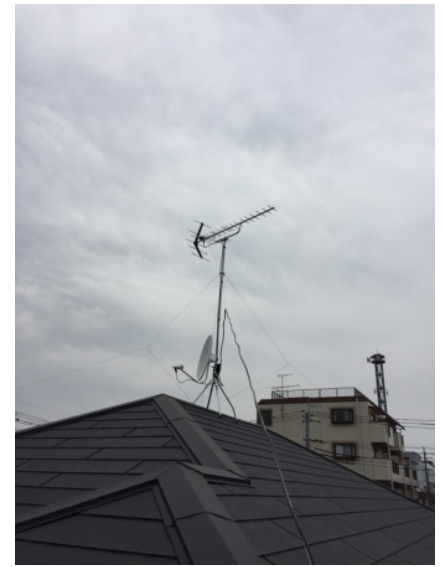
飯能市緑町 一建設様物件 地デジアンテナとBSアンテナ屋根上工事
