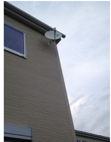
飯能市笹縫 タクトホーム様物件 壁面取付 B Sアンテナ工事
