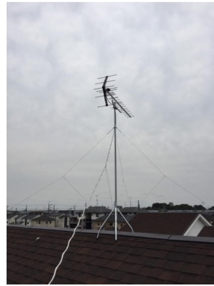
白岡市西 ケイアイスター不動産様物件 地デジアンテナ屋根上工事
