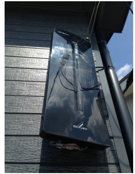
白岡市西 ケイアイスター不動産様物件 壁面取付 デザインアンテナ工事
