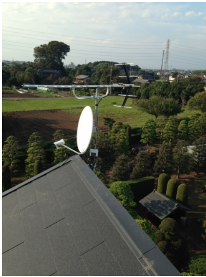
白岡市実ケ谷 開成コーポレーション様物件 壁面取付 地デジアンテナとBSアンテナ工事
