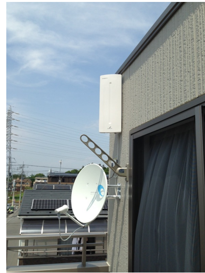
さいたま市見沼区大和田町 トヨタホーム様物件 壁面取付 デザインアンテナとBSアンテナ工事
