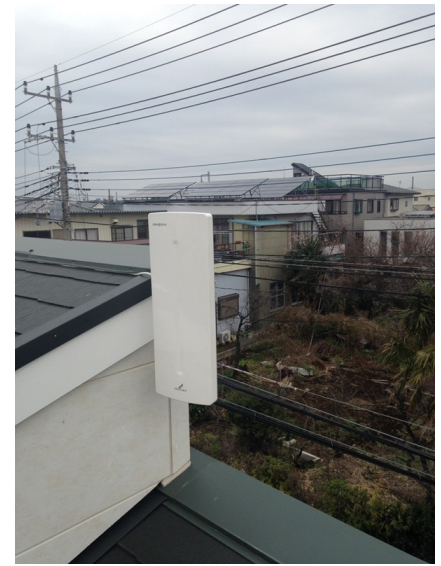
さいたま市見沼区小深作 三建アーキテクト様物件 壁面取付 デザインアンテナ工事
