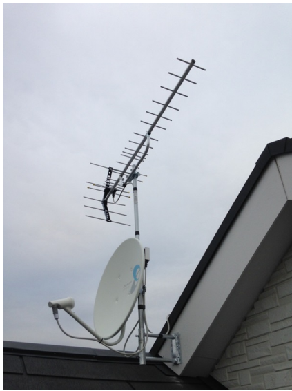
さいたま市見沼区大谷 飯田産業様物件 壁面取付 地デジアンテナとBSアンテナ工事
