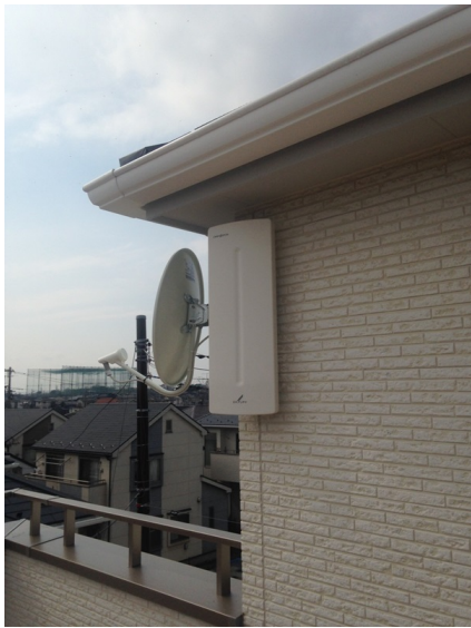
さいたま市見沼区南中野 ポラス様物件 壁面取付 デザインアンテナとBSアンテナ工事
