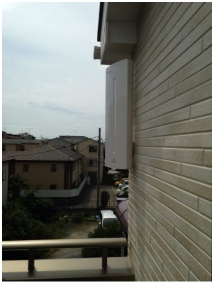
さいたま市南区文蔵 壁面取付 デザインアン テナ工事
