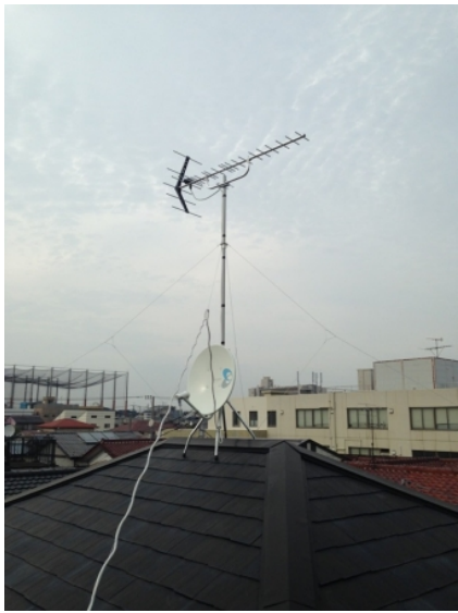
さいたま市南区太田窪 地デジアンテナとBSアンテナ屋根上工事
