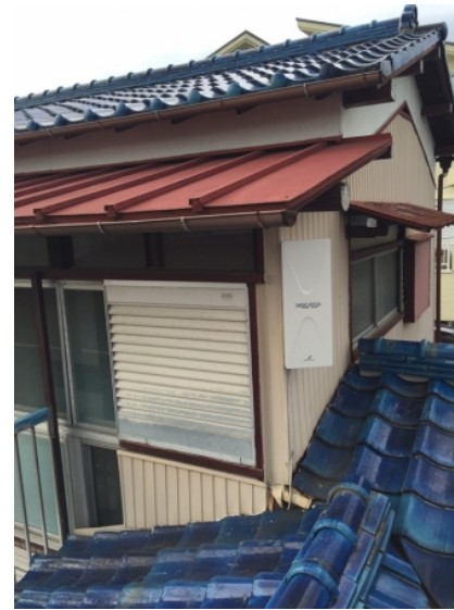
さいたま市南区辻 壁面取付 デザインアンテナ工事
