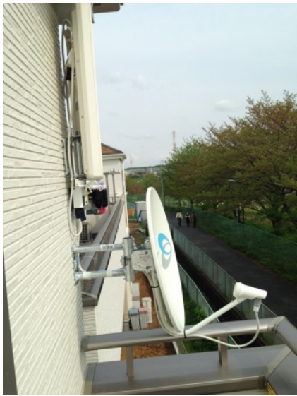
さいたま市南区太田窪 飯田産業様物件 壁面取付 デザインアンテナとBSアンテナ工事
