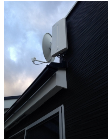
さいたま市南区別所 壁面取付 デザインアンテナとBSアンテナ工事
