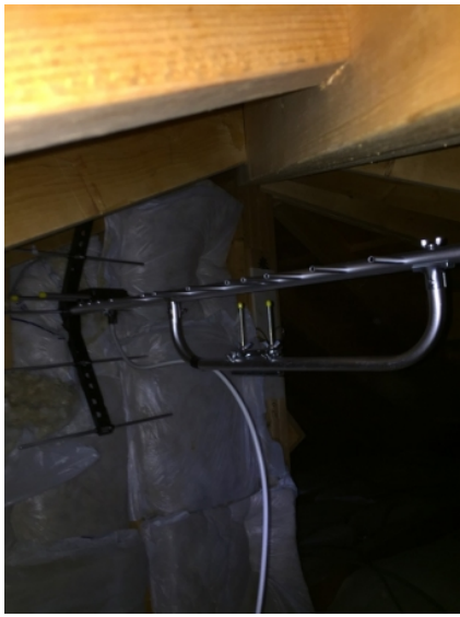
さいたま市南区大谷場 エアスティール様物件 地デジアンテナ屋根裏工事
