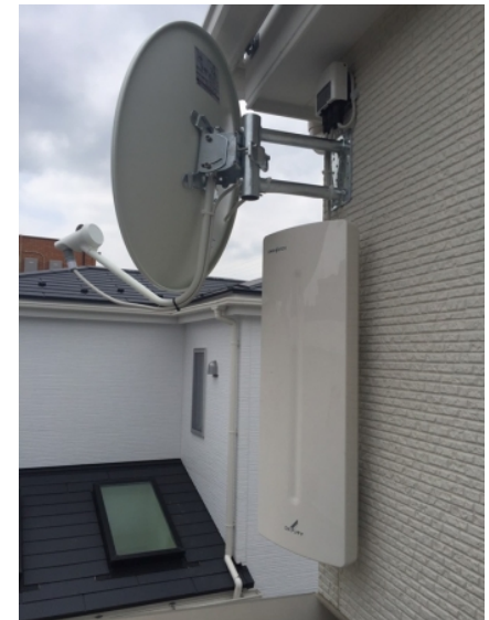
さいたま市南区辻 壁面取付 デザインアンテナとBSアンテナ工事
