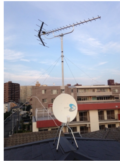
さいたま市南区白幡 地デジアンテナとBSアンテナ屋根上工事
