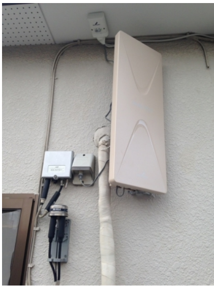
さいたま市南区曲本 壁面取付 デザインアンテナ工事
