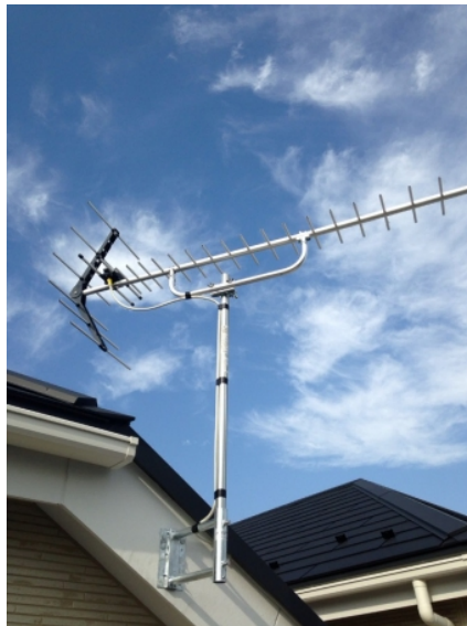
さいたま市南区太田窪 壁面取付 地デジアンテ ナ工事
