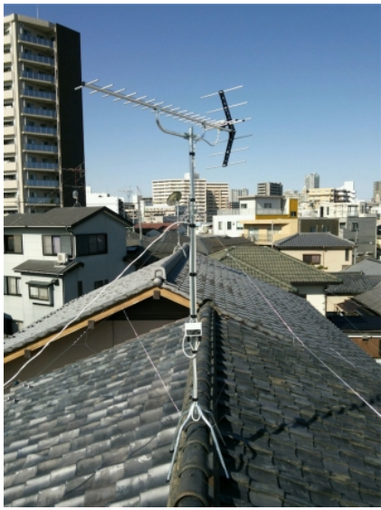
さいたま市南区根岸 地デジアンテナ屋根上工事
