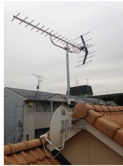
さいたま市南区南浦和 壁面取付 地デジアンテナとBSアンテナ工事
