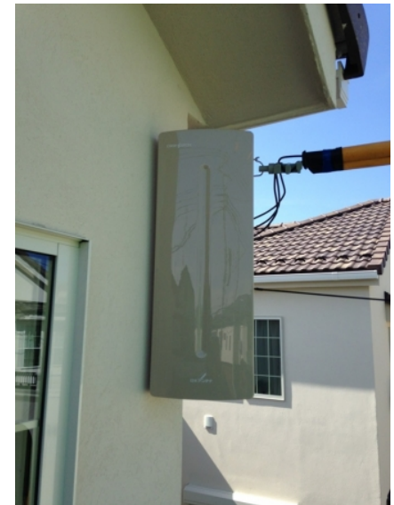
さいたま市南区広ヶ谷戸 ナビハウジング様物件 壁面取付 デザインアンテナ工事
