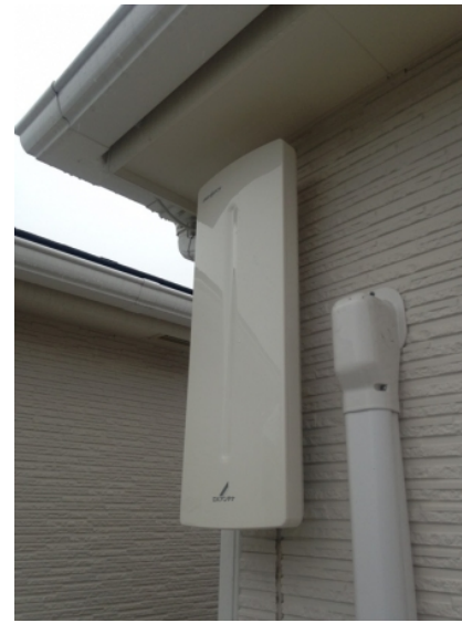
さいたま市南区円正寺 ポラス様物件 壁面取付 デザインアンテナ工事
