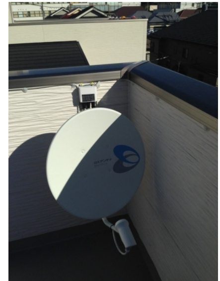
さいたま市南区大谷場 ゼロシステム様物件 壁面取付 BSアンテナ工事
