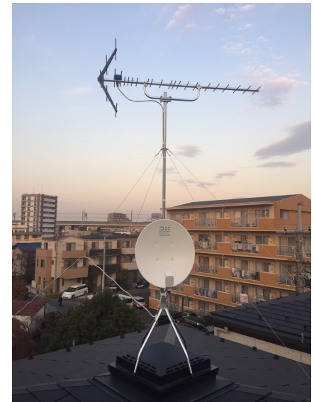
さいたま市南区鹿手袋 ダイワハウス様ご物件 屋根上設置 八木式アンテナとBS/CSアンテナ工 事
