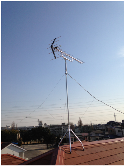
さいたま市南区大谷口 昭栄建設様ご物件 屋根上設置 八木式アンテナ工事
