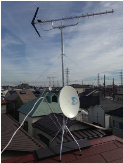
さいたま市南区大谷口 ポラス様物件 地デジアンテナとBSアンテナ屋根上工事
