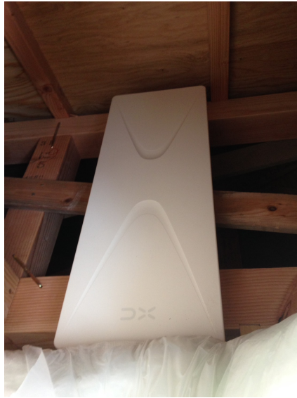
さいたま市南区 屋根裏設置 デザインアンテナ工事
