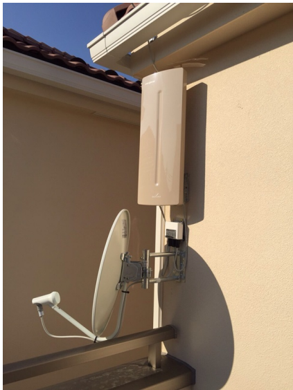
さいたま市浦和区瀬ヶ崎 ゼロホーム様物件 壁面取付 デザインアンテナとBSアンテナ工事
