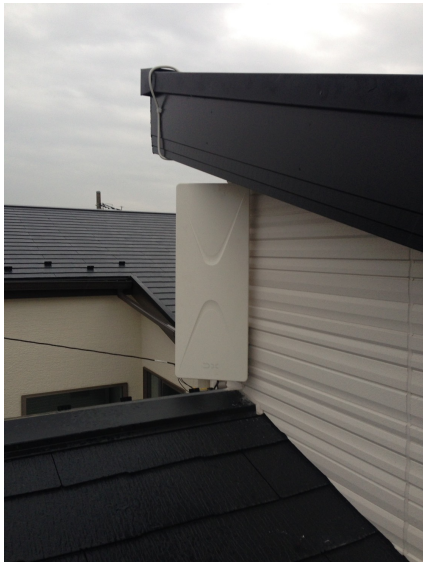
浦和区大東 ナビホーム様ご物件 壁面取付 デザインアンテナ工事
