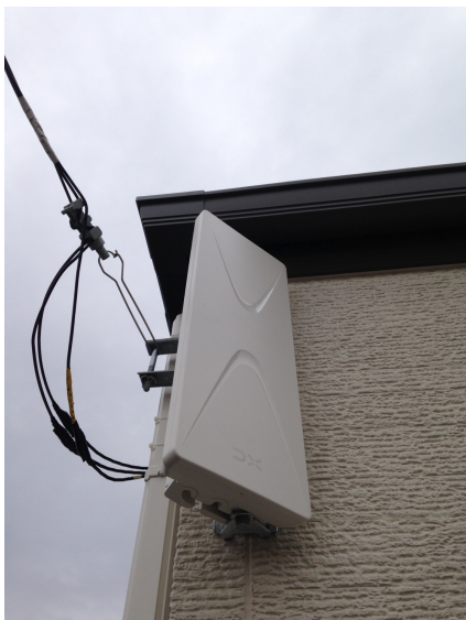
さいたま市浦和区大東 ナビハウジング様ご物件 壁面取付 デザインアンテナ工事
