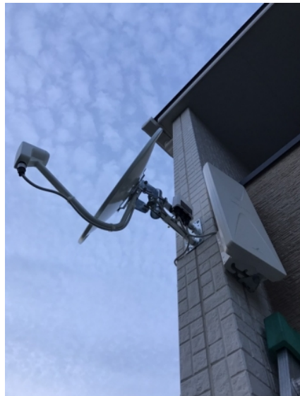
さいたま市大宮区三橋 永大様物件 壁面取付 デザインアンテナとBSアンテナ工事
