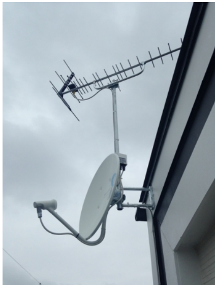
さいたま市大宮区上小町 三栄建築設計様物件 壁面取付 地デジアンテナとBSアンテナ工事
