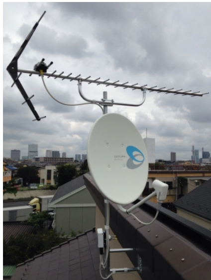
さいたま市大宮区三橋 壁面取付 地デジアンテナとBSアンテナ工事
