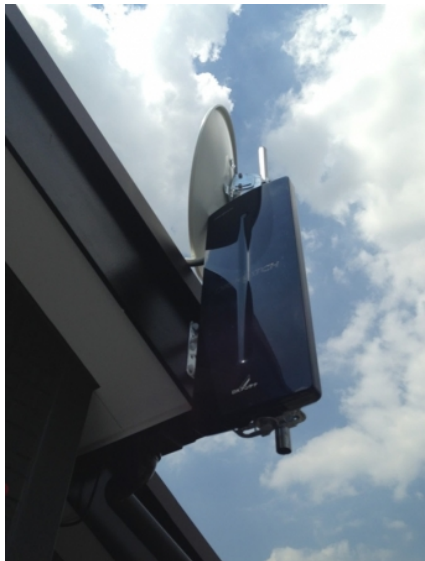
さいたま市大宮区三橋 三栄ホーム様物件 壁面取付 デザインアンテナとBSアンテナ工事
