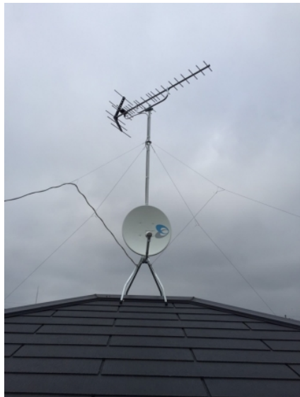
さいたま市大宮区天沼町 アベルト様物件 地デジアンテナとBSアンテナ屋根上工事
