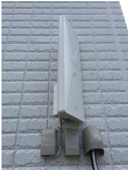
さいたま市大宮区堀の内町 松永住宅様物件 壁面取付 デザインアンテナ工事
