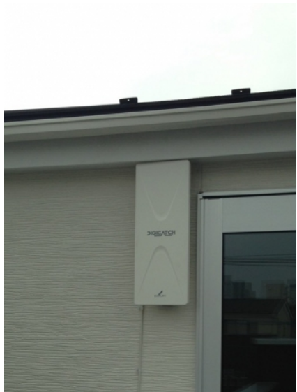
さいたま市大宮区上小町 三栄建築設計様物件 壁面取付 デザインアンテナ工事
