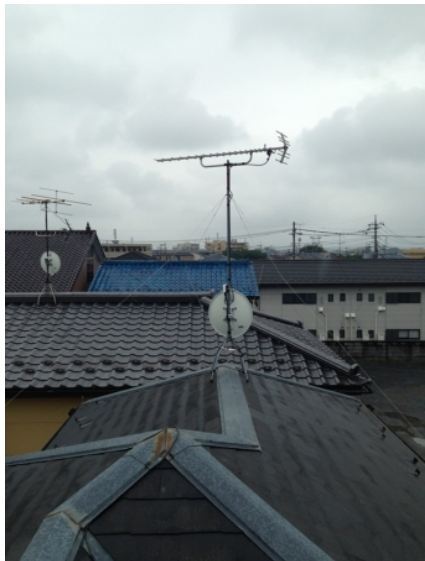
さいたま市大宮区三橋 ナビホーム様物件 地デジアンテナとBSアンテナ屋根上工事
