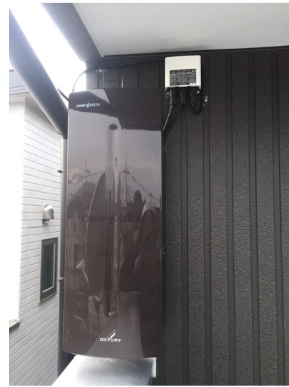
さいたま市緑区東浦和 大貫様物件 壁面取付 デザインアンテナ工事
