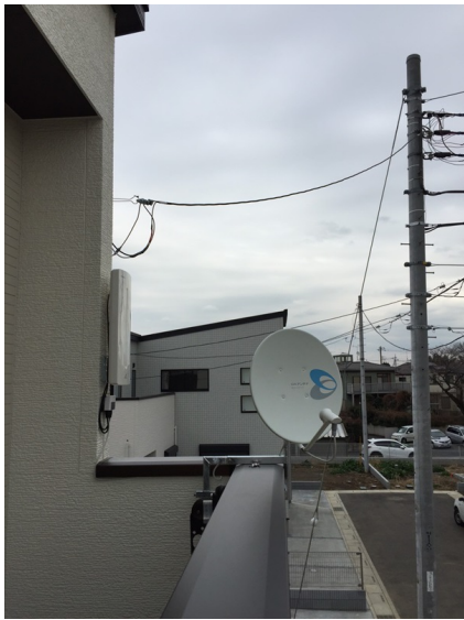
さいたま市緑区大間木 永大様物件 デザインアンテナとBSアンテナ工事
