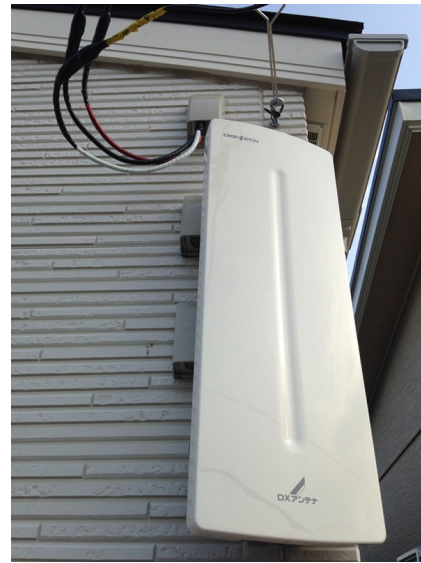
さいたま市緑区中尾 永大様物件 壁面取付 デザインアンテナ工事
