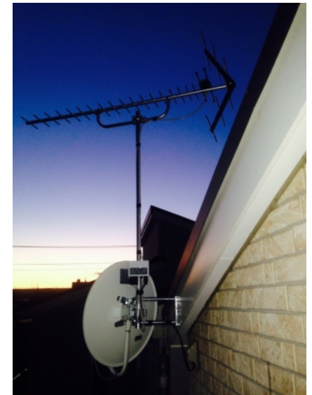
さいたま市中央区本町西 壁面取付 地デジアンテナとBSアンテナ工事
