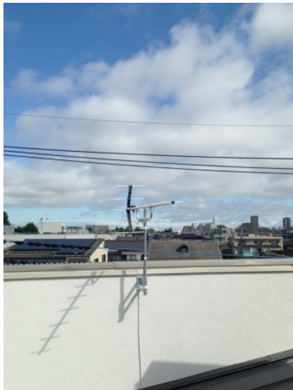
さいたま市中央区鈴谷 ハウスネットワーク様物件 挟み込み取付 地デジアンテナ工事
