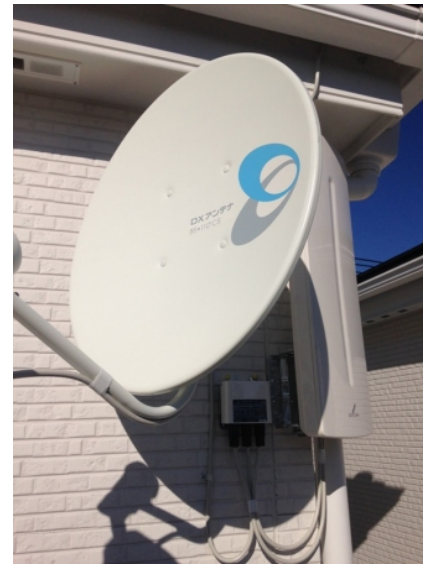
さいたま市中央区下落合 ベストセレクト様物件 壁面取付 デザインアンテナとBSアンテナ工事
