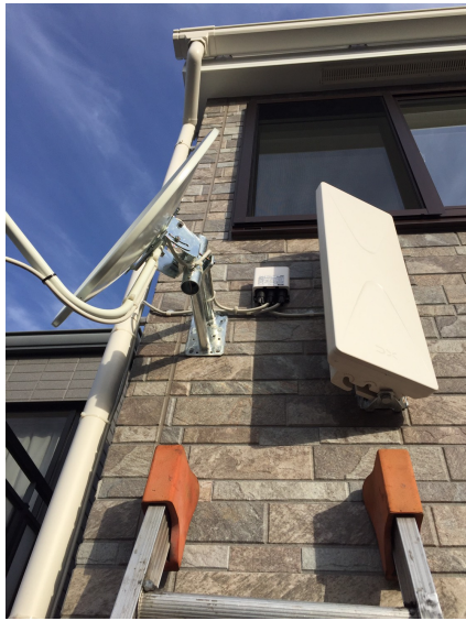
さいたま市中央区新中里 壁面取付 デザインアンテナ工事
