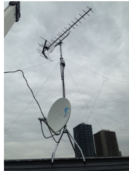
さいたま市中央区上落合 地デジアンテナとBSアンテナ屋根上工事
