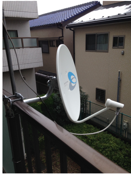
さいたま市中央区下落合 ベランダ手すり取付 BSアンテナ工事
