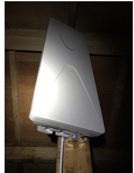
北葛飾郡松伏町ゆめみ野 屋根裏設置 デザインアンテナ工事
