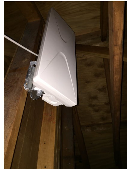
北葛飾郡松伏町ゆめみ野 屋根裏設置 デザインアンテナ工事
