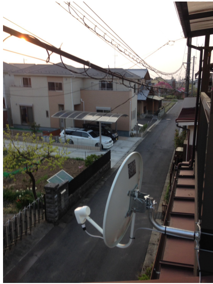
北葛飾郡杉戸町清地 ベランダ手すり取付 BSアンテナ工事
