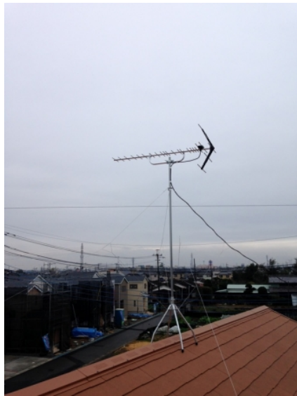
北葛飾郡杉戸町倉松 山崎建設様物件 地デジアンテナ屋根上工事
