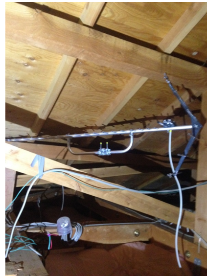
さいたま市岩槻区西平野 地デジアンテナ屋根裏工事
