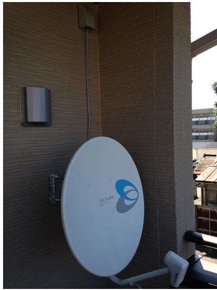
さいたま市岩槻区本町 壁面取付 BSアンテナ工事
