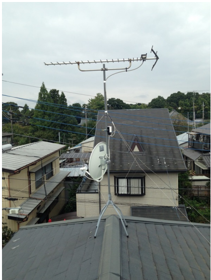
さいたま市岩槻区柏崎 地デジアンテナとBS/CSアンテナ工事
