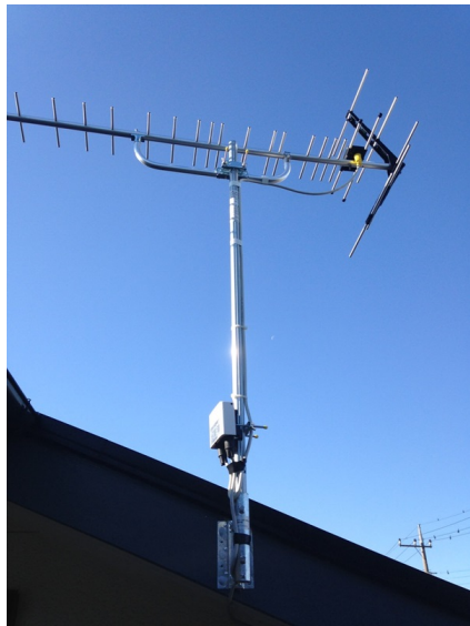
さいたま市岩槻区府内 壁面取付 地デジアンテナ工事
