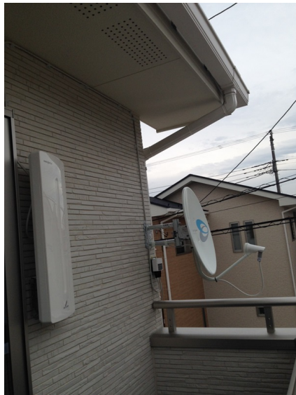
さいたま市岩槻区釣上新田 壁面取付 デザインアンテナとBSアンテナ工事
