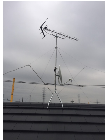
さいたま市岩槻区釣上新田 三井ホーム様物件 地デジアンテナとBSアンテナ屋根上工事
