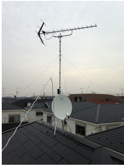
さいたま市岩槻区西町 屋根上設置 八木式アンテナとBS/CSアンテナ工 事
