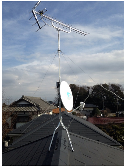
さいたま市岩槻区黒谷 一建設様物件 地デジアンテナとBSアンテナ屋根上工事
