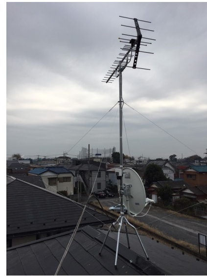
さいたま市岩槻区本町 アサヒ住建様物件 地デジアンテナとBSアンテナ屋根上工事
