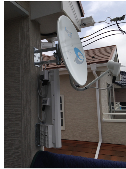
さいたま市岩槻区西町 一建設様物件 デザインアンテナとBSアンテナ工事
