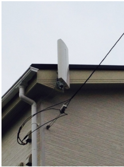
鴻巣市北新宿 壁面取付 デザインアンテナ工事
