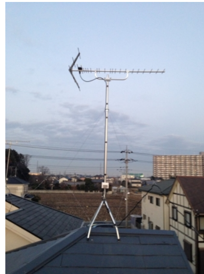
鴻巣市松原 地デジアンテナ屋根上工事
