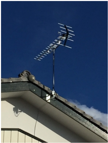
鴻巣市松原 壁面取付 地デジアンテナ工事
