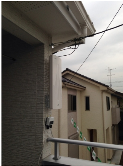
鴻巣市大間 壁面取付 デザインアンテナ工事
