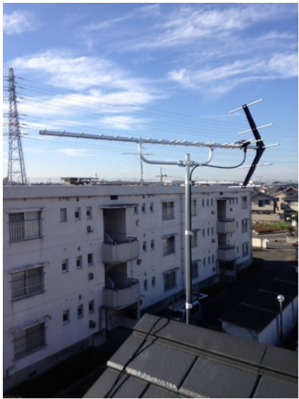
鴻巣市鴻巣 壁面取付 地デジアンテナ工事
