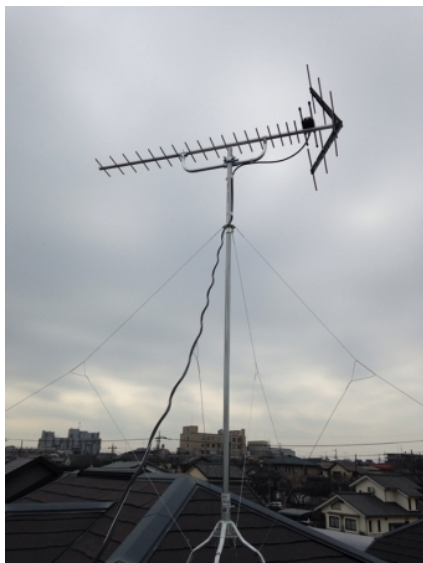
川崎市氷川町 地デジアンテナ屋根上工事
