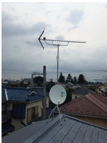
川崎市砂新田 地デジアンテナとBSアンテナ屋根上工事
