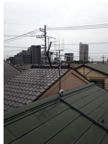
川崎市藤間 壁面取付 地デジアンテナ工事
