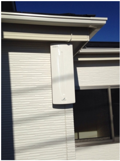
川越市藤間 壁面取付 デザインアンテナ工事
