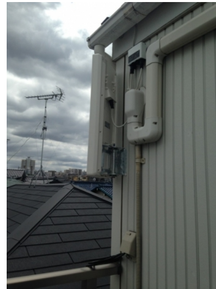
川越市寺尾 デザインアンテナの壁面取り付け
