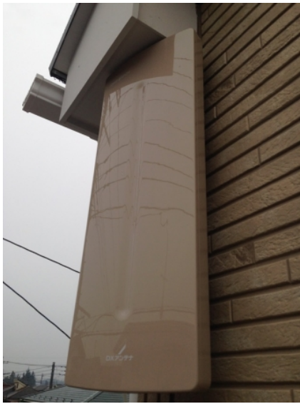
川越市吉田 壁面取付 デザインアンテナ工事
