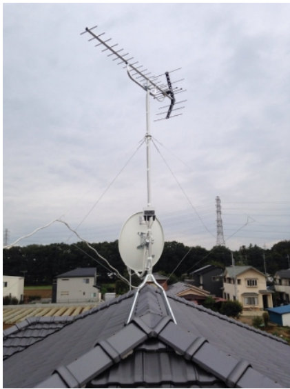
川越市下赤坂 地デジアンテナとBSアンテナ屋根上工事
