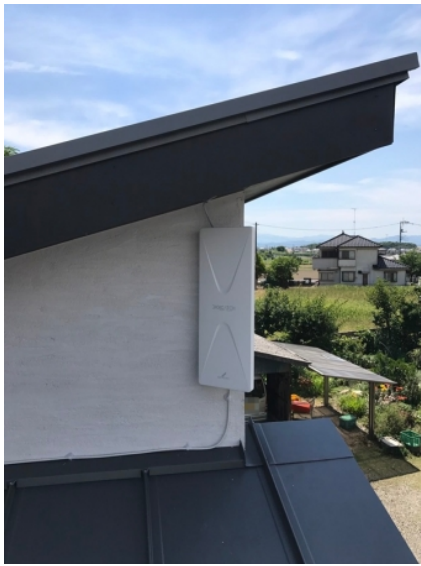
川越市大袋新田 シバタスペース様物件 壁面取付 デザインアンテナ工事
