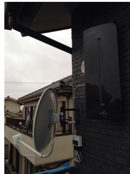
川越市今成 壁面取付 デザインアンテナとBSアンテナ工事
