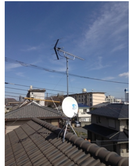
川越市南台 千代田ホーム様物件 地デジアンテナとBSアンテナ屋根上工事
