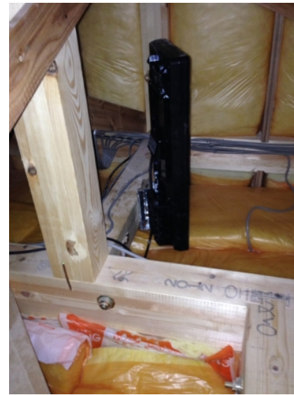
川越市大塚新町 住協建設様物件 デザインアンテナ屋根裏工事
