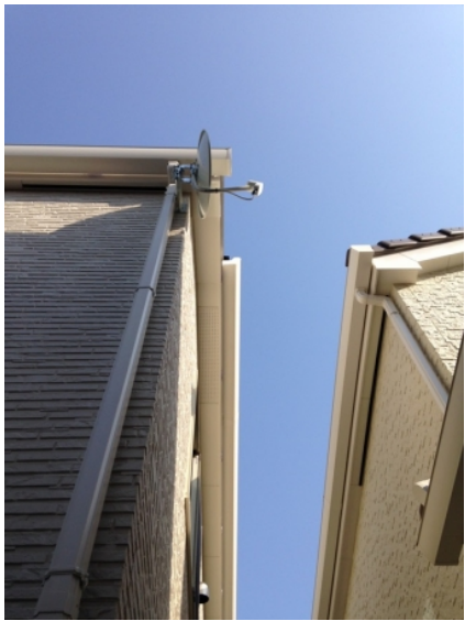
川越市大塚新町 住協建設様物件 壁面取付 BSアンテナ工事
