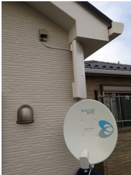
川越市中台南 住協建設様物件 壁面取付 デザインアンテナとBSアンテナ工事
