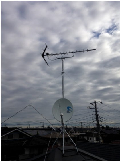
川越市今成 地デジアンテナとB Sアンテナ屋根上工事
