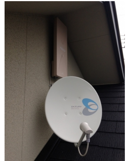
川越市小ヶ谷 一条工務店様物件 壁面取付 デザインアンテナとB Sアンテナ工事
