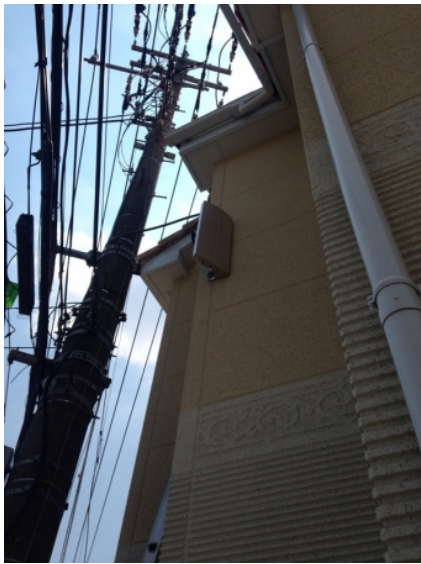
川越市今福 千代田産業様物件 壁面取付 デザインアンテナ工事
