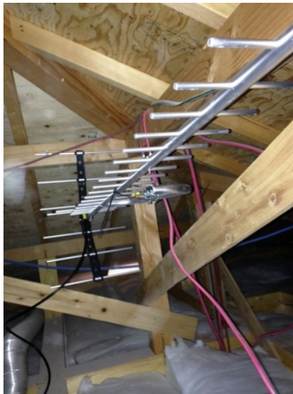
川越市仙波町 ボラス様物件 地デジアンテナ屋根裏工事
