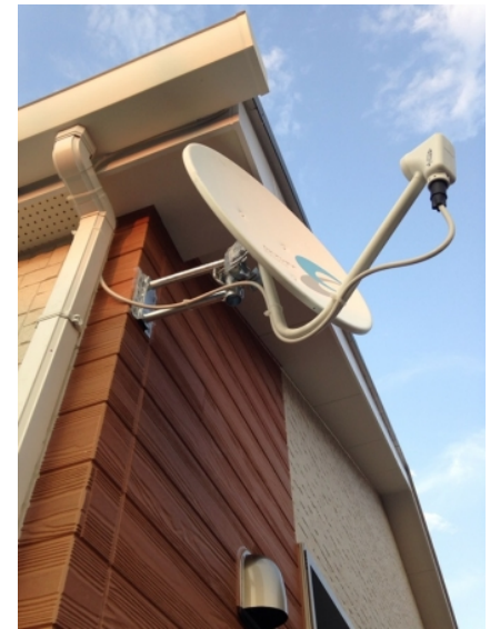
川越市新宿町 住協建設様物件 壁面取付 BSアンテナ工事
